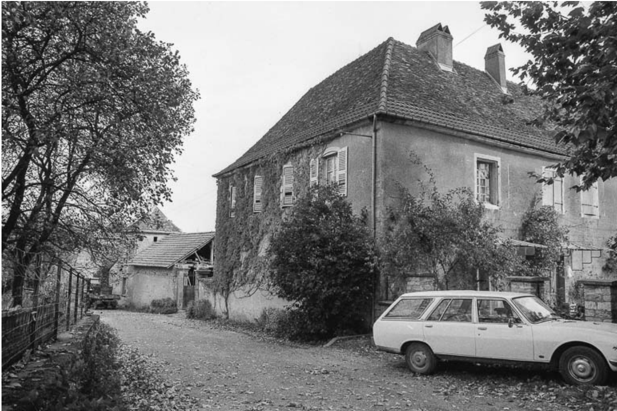
Façades latérale droite et postérieure.
