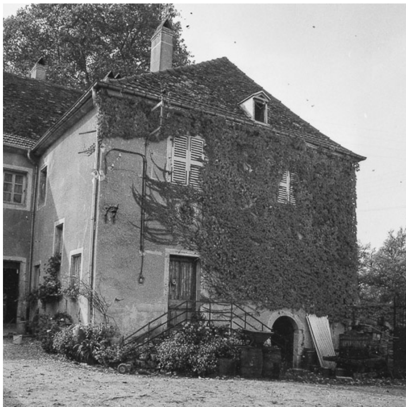
Habitation vue depuis la cour.
