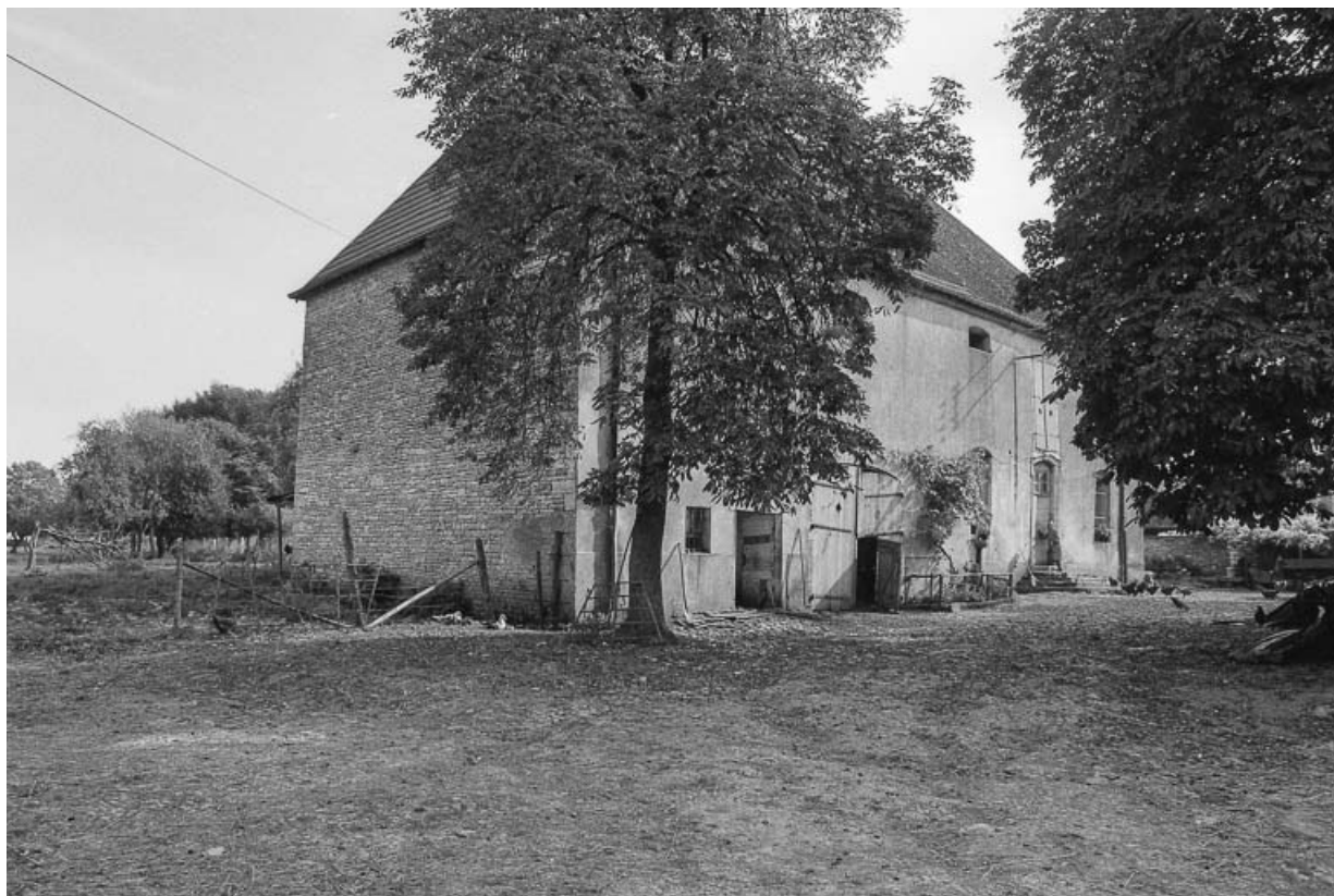
Vue de la maison d'habitation depuis la cour.
