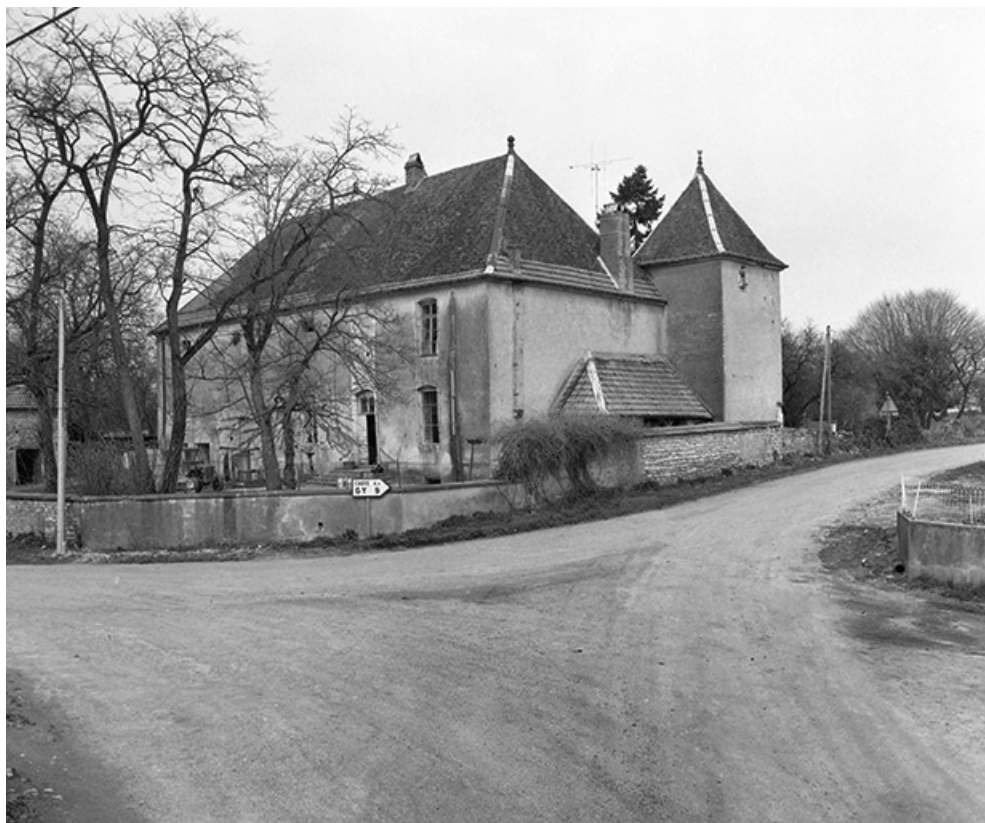
Façade antérieure sur cour.
