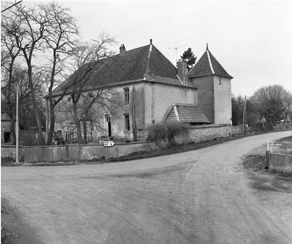
Façade antérieure sur cour.
