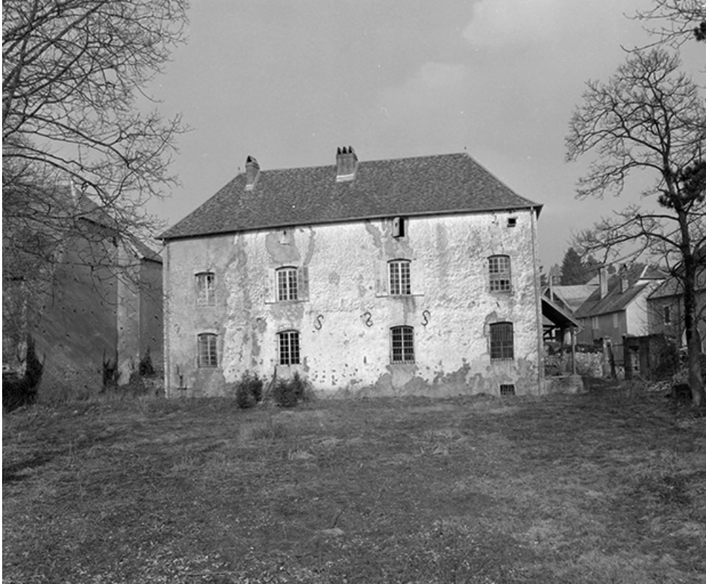
Façade sur le parc.
