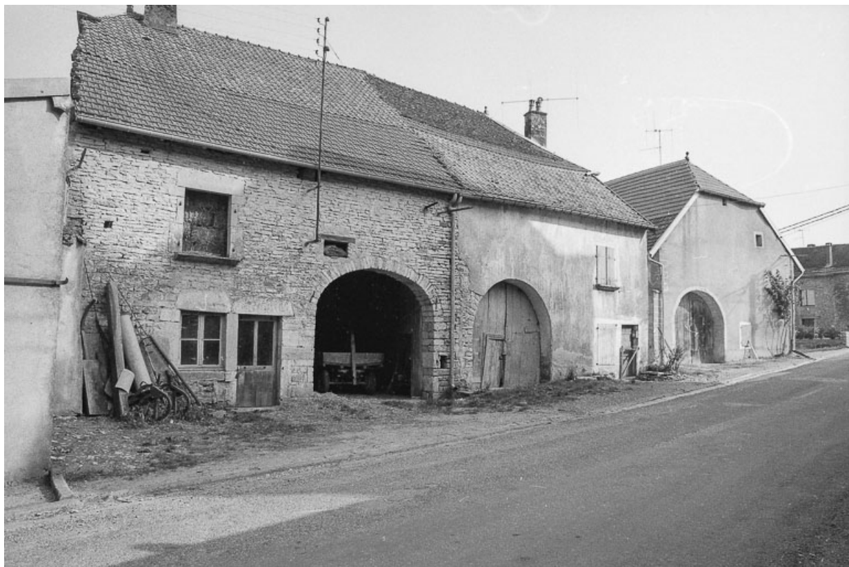
Façade antérieure vue de trois quarts gauche.
