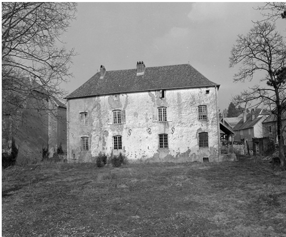
Façade sur le parc.
