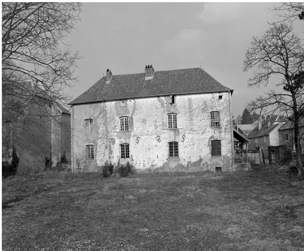
Façade sur le parc.
