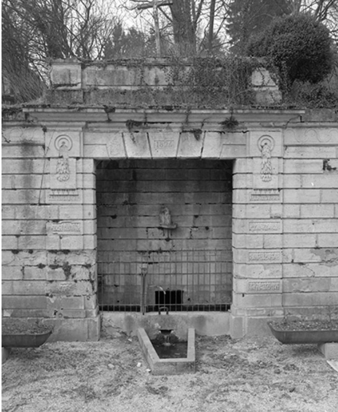
Vue de la partie centrale.
