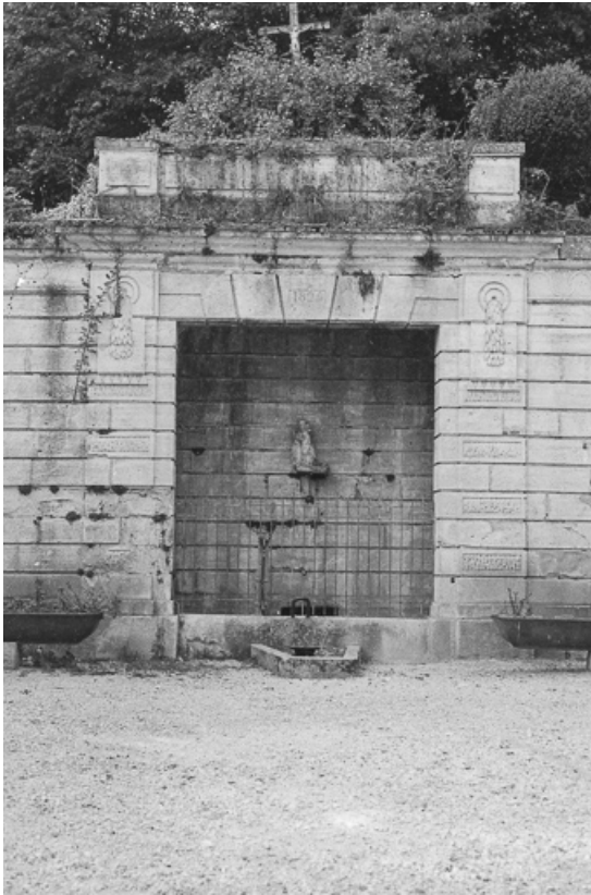
Vue de la partie centrale.
