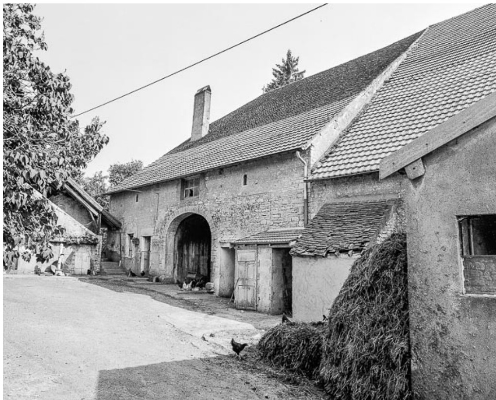
Bâtiment de droite : façade antérieure.
