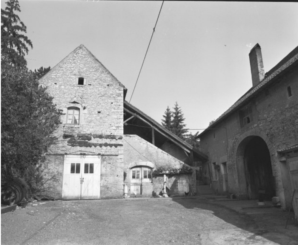
Ensemble des bâtiments : façades sur cour.
