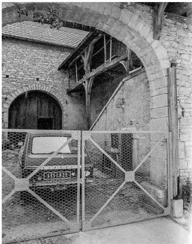
Cour intérieure, côté droit : escalier.
