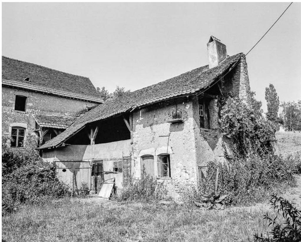
Façade antérieure et aile droite.
