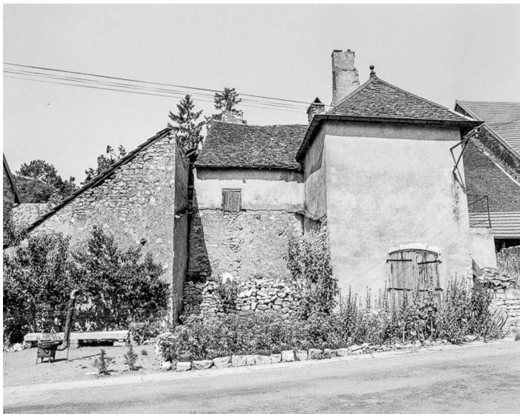
Façades postérieure et latérale gauche.
