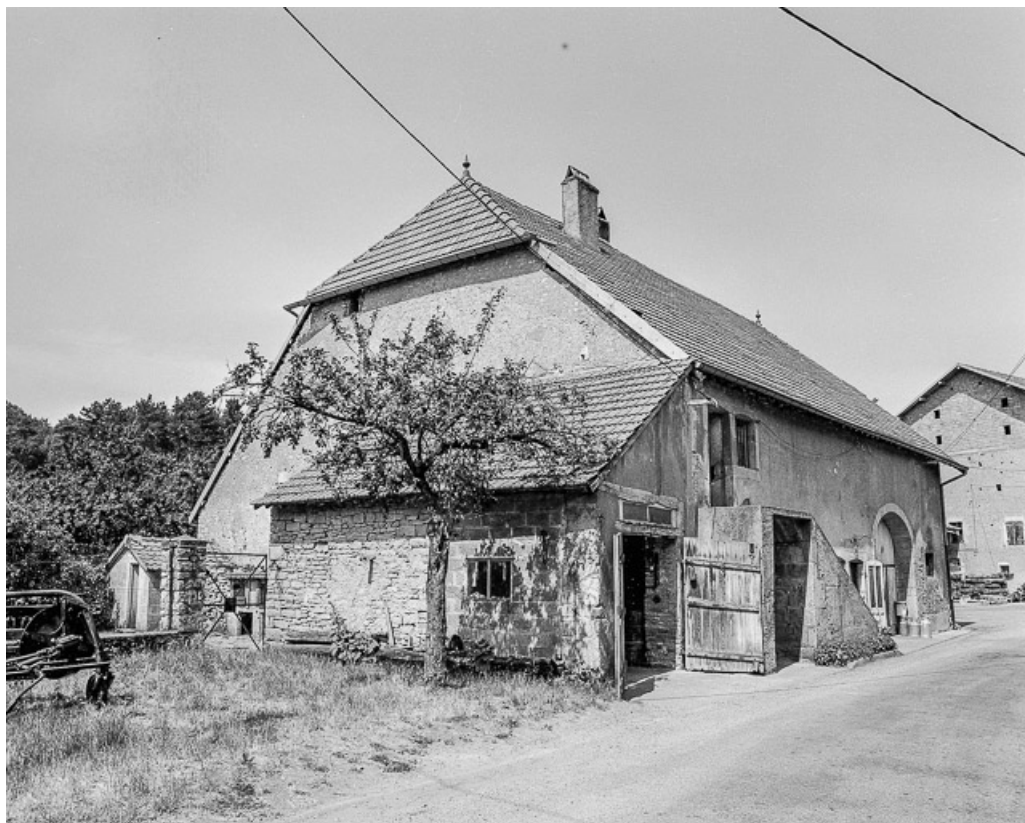
Façade antérieure et façade latérale gauche. 70, Chenevrey-et-Morogne
