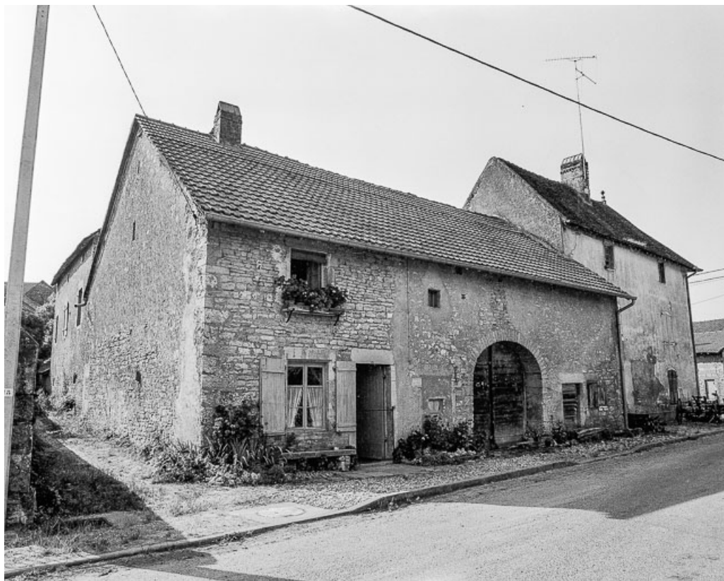
Façades antérieure et latérale gauche.
