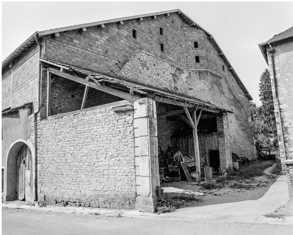
Hangar situé à gauche de la maison.
