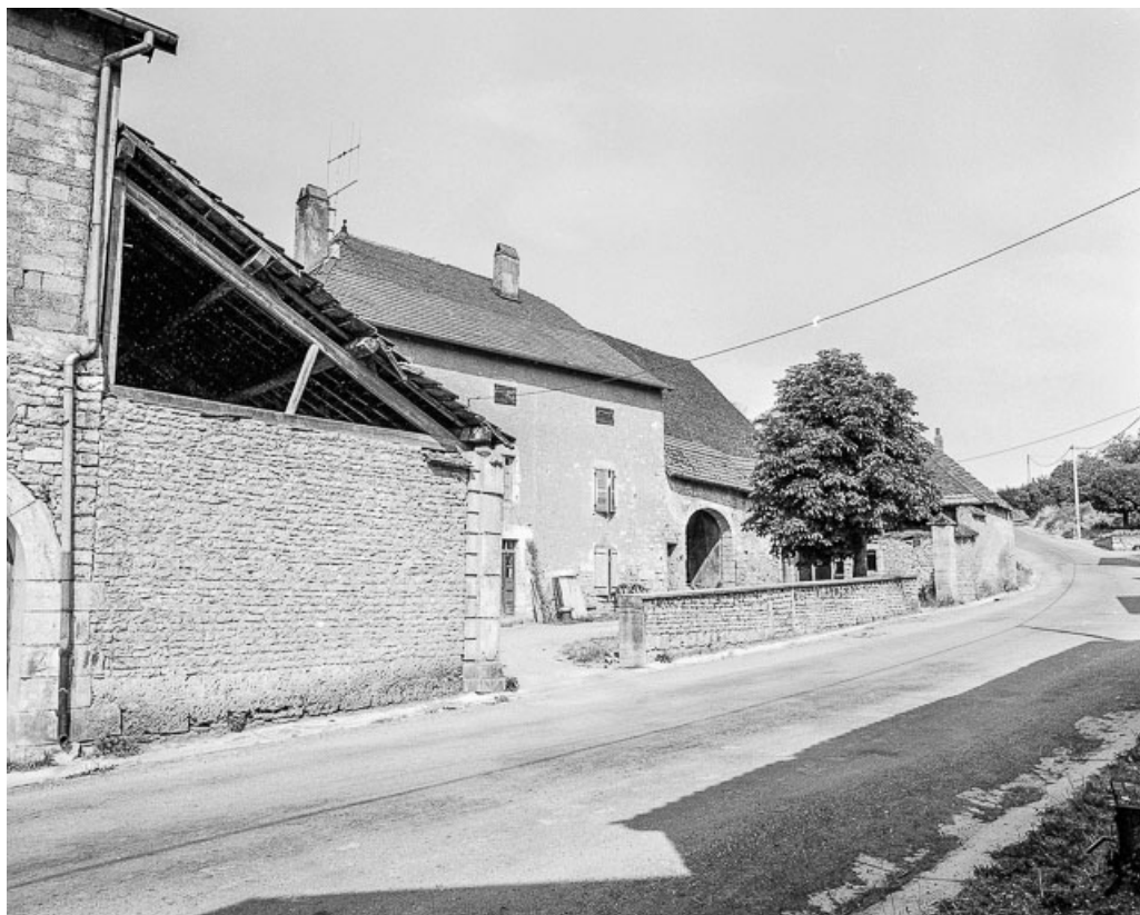
Façade antérieure et cour. 70, Chenevrey-et-Morogne
