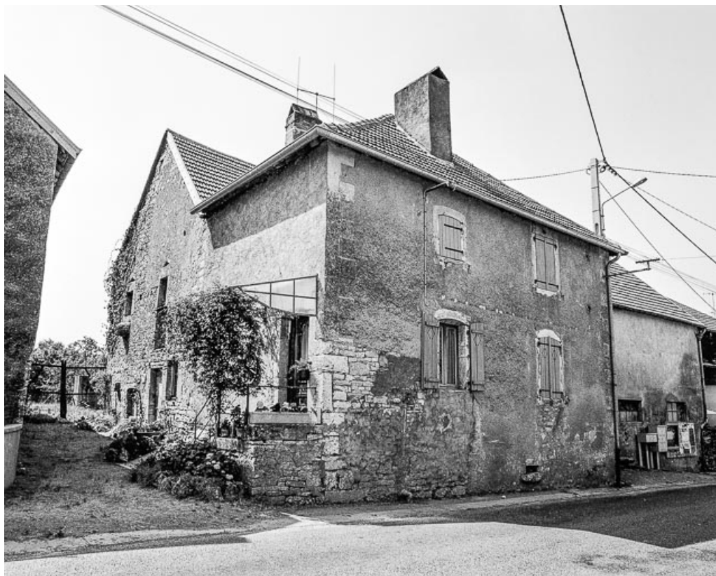
Façades antérieure et latérale droite sur la rue. 70, Chenevrey-et-Morogne
