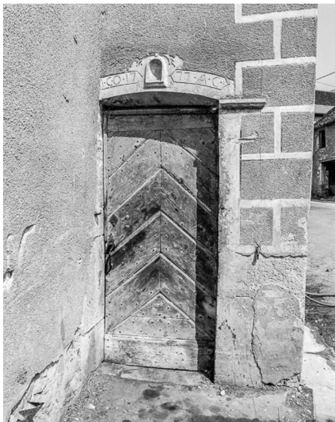
Détail de la porte de la façade antérieure.
