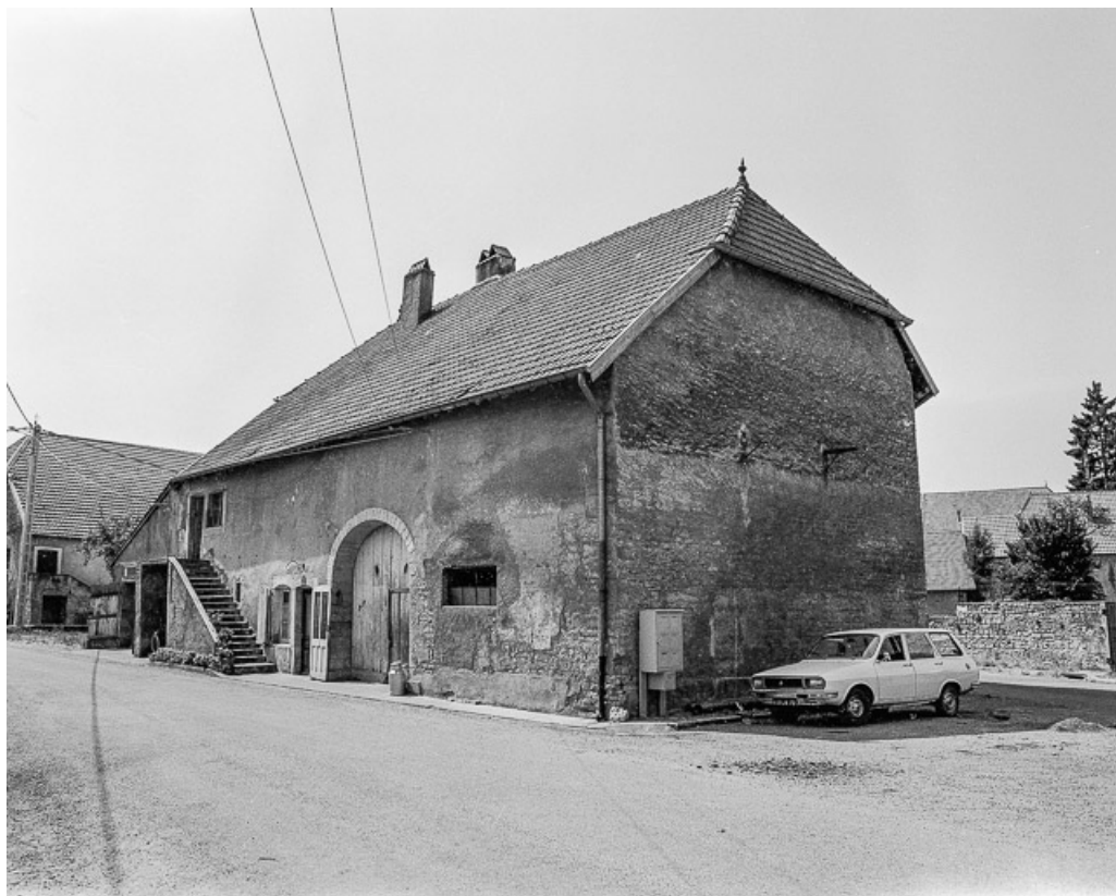
Façade antérieure et façade latérale droite.
