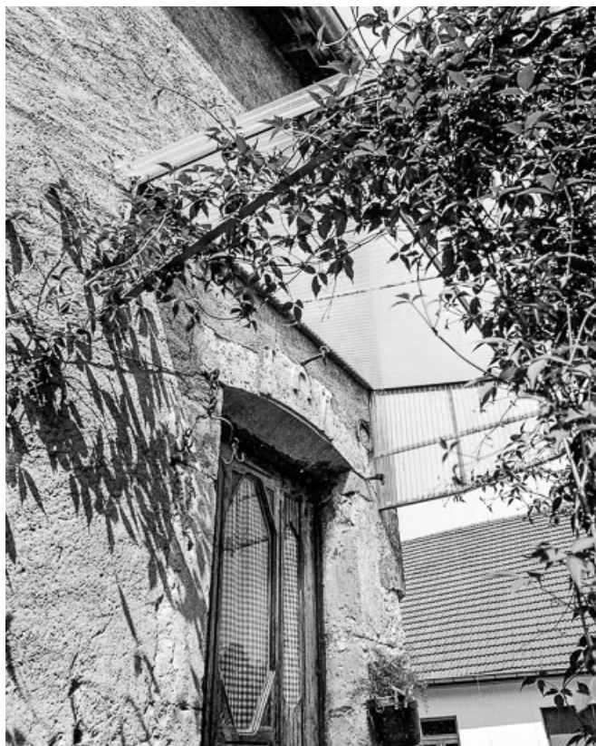
Détail de la porte d'entrée.
