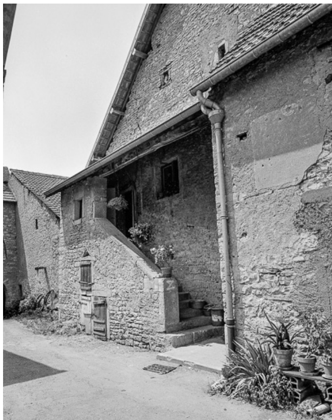
Escalier, façade antérieure.
