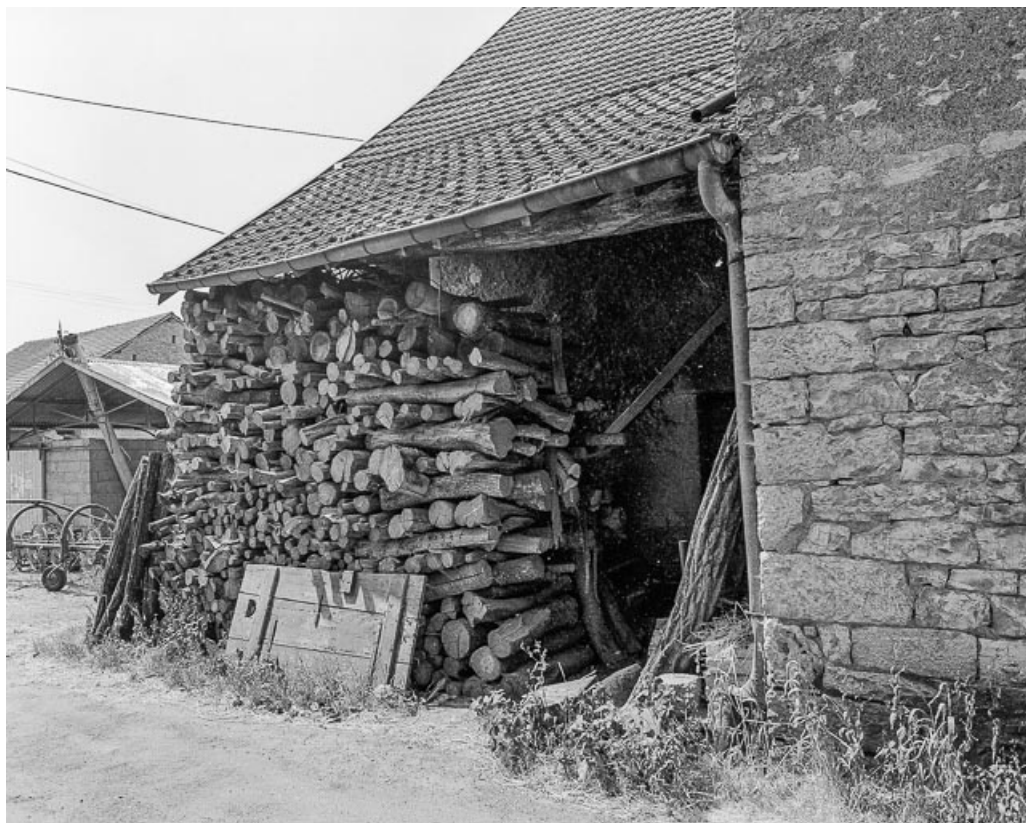
Façade latérale droite.
