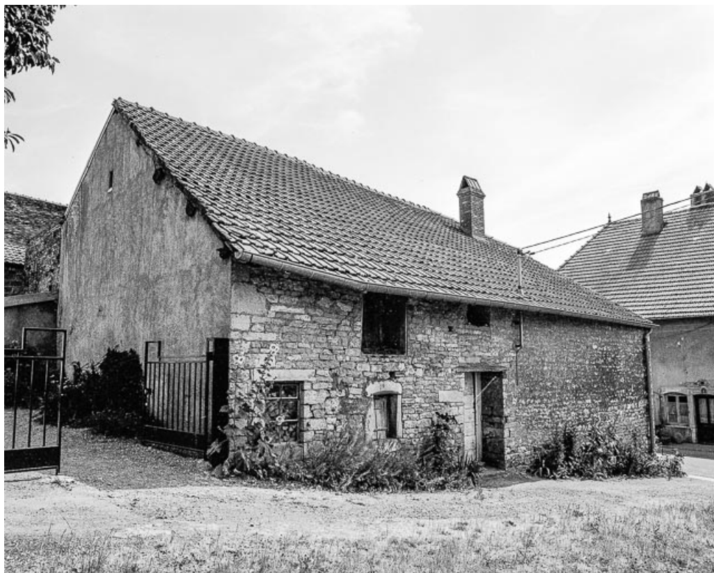
Façade latérale gauche.
