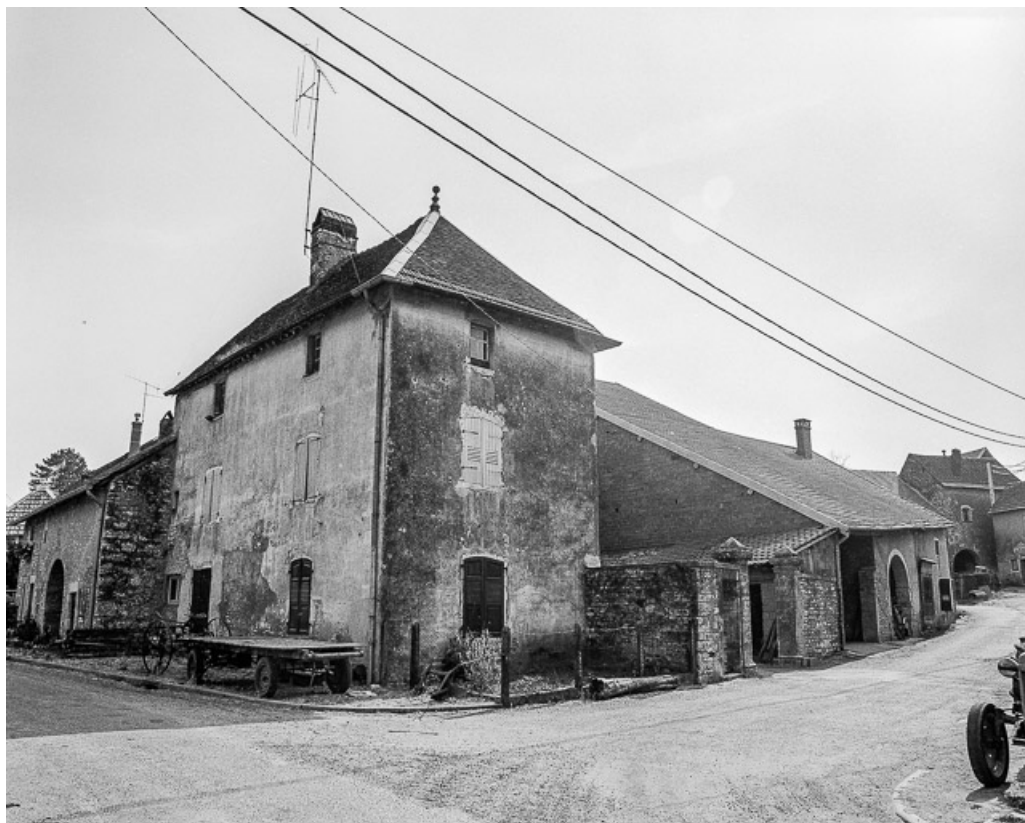
Façade donnant sur la rue et entrée de la cour. 70, Chenevrey-et-Morogne
