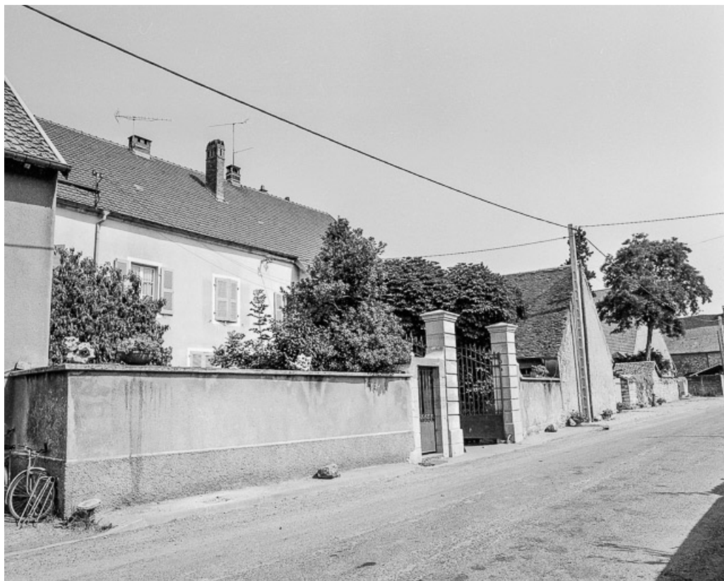
Façade antérieure et cour. 70, Chenevrey-et-Morogne
