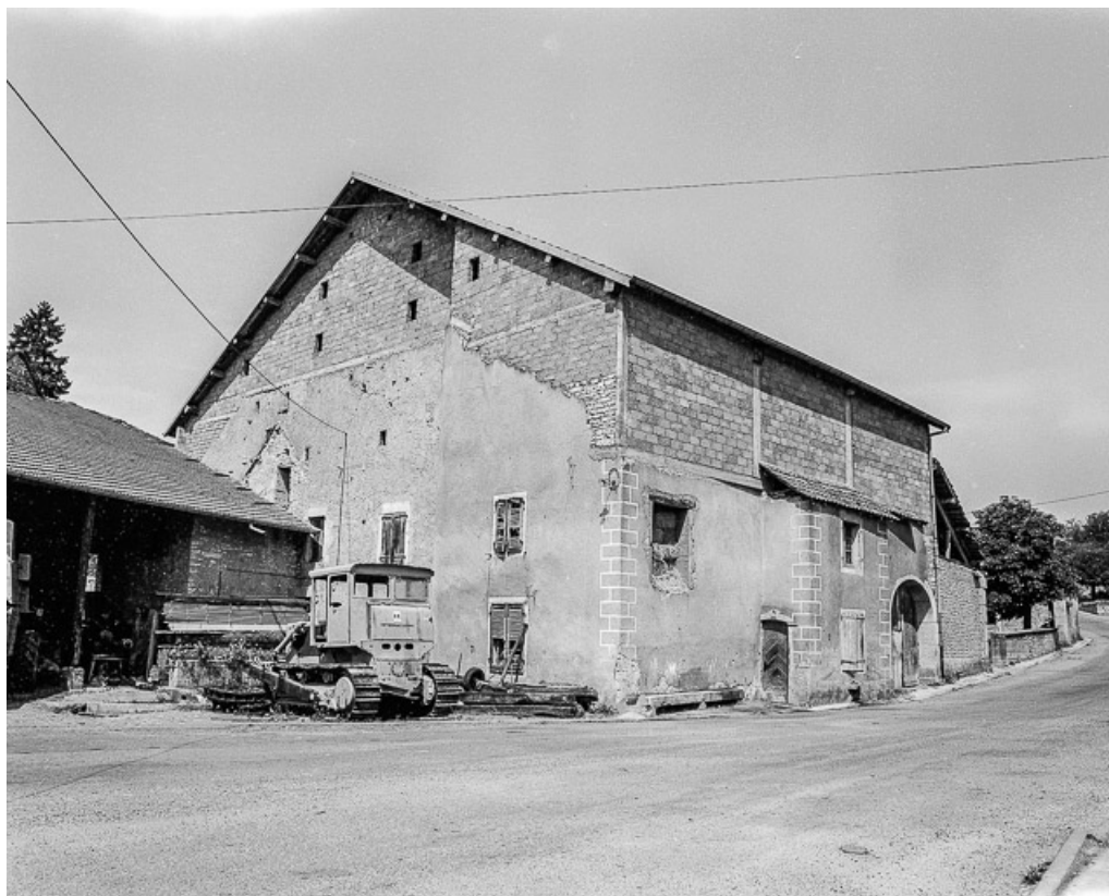
Façades antérieure et latérale gauche.
