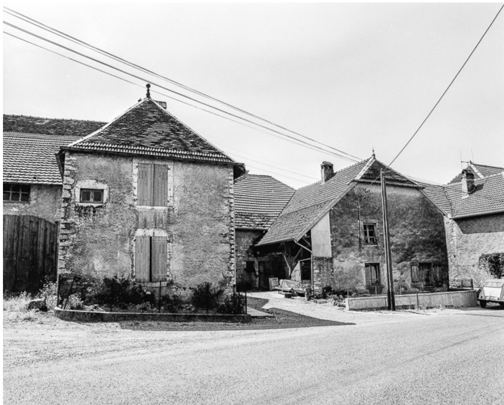
Façades donnant sur la rue.
