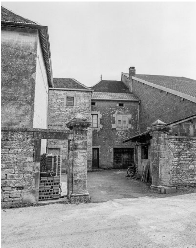
Façade donnant dans la cour.
