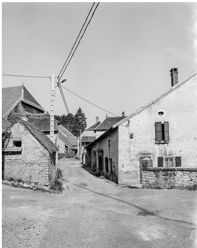
Façades antérieure et latérale gauche.
