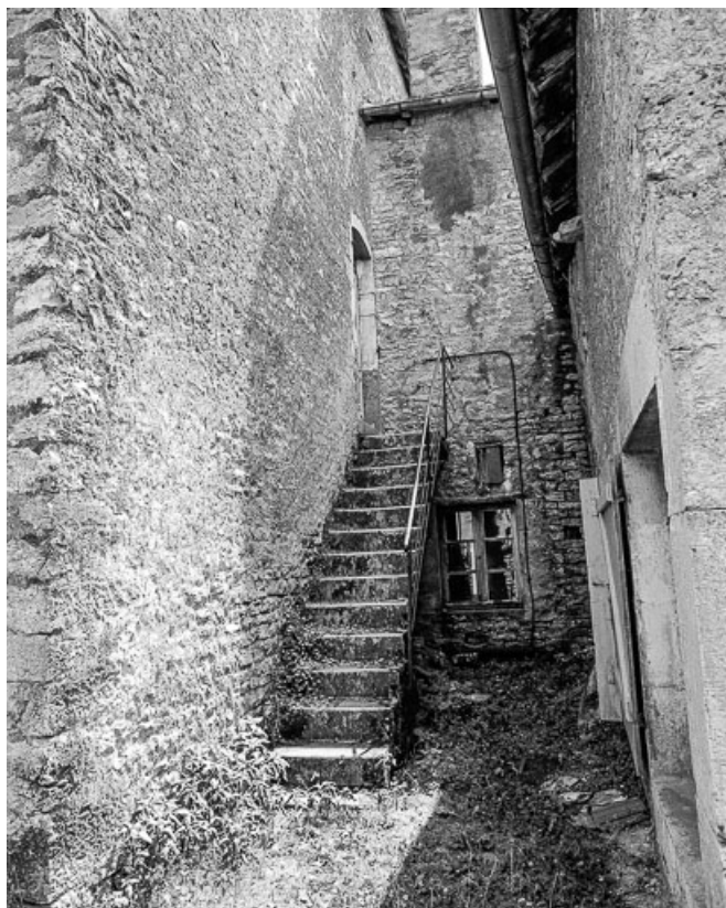
Façade postérieure avec escaliers.
