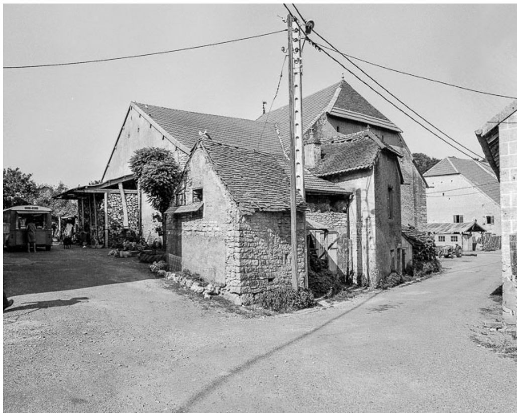
Ensemble de maisons et de fermes vues depuis le haut de la rue. 70, Chenevrey-et-Morogne
