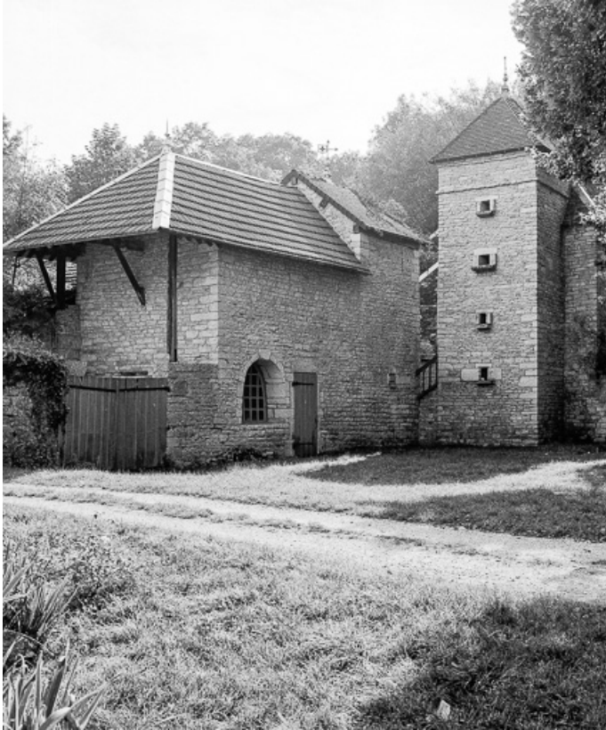
Façade principale, partie gauche.
