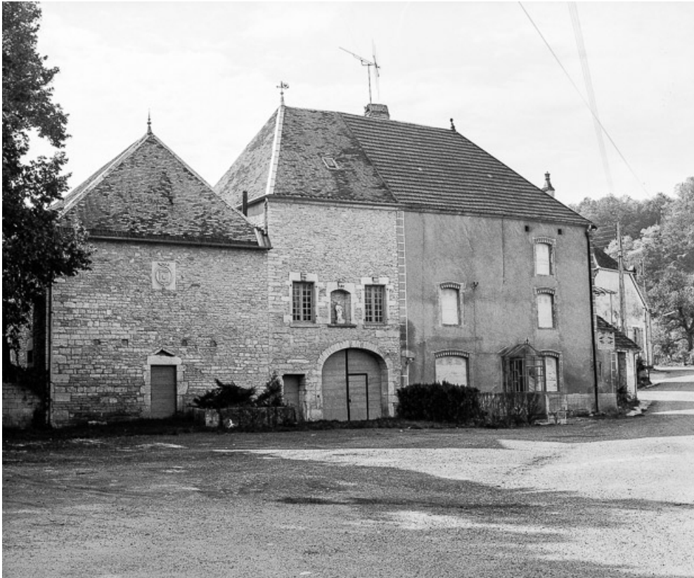
Façade principale, partie droite.
