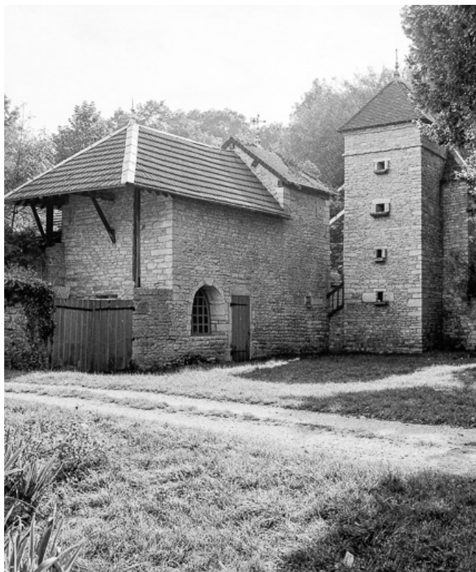
Façade principale, partie gauche.
