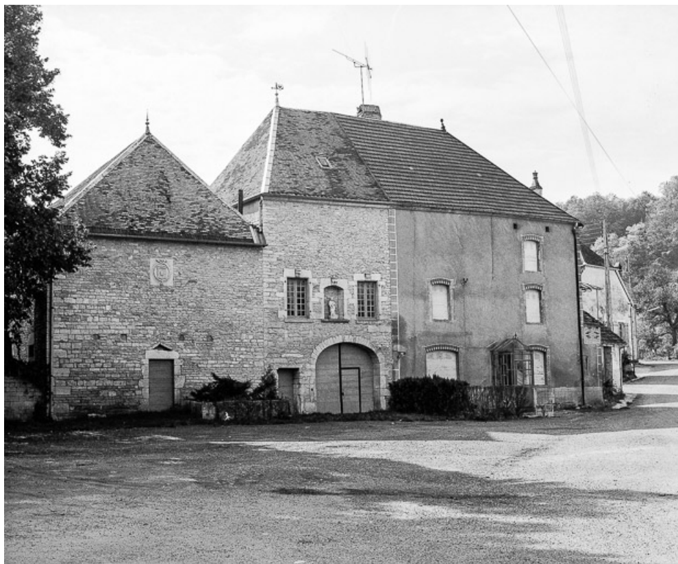
Façade principale, partie droite.
