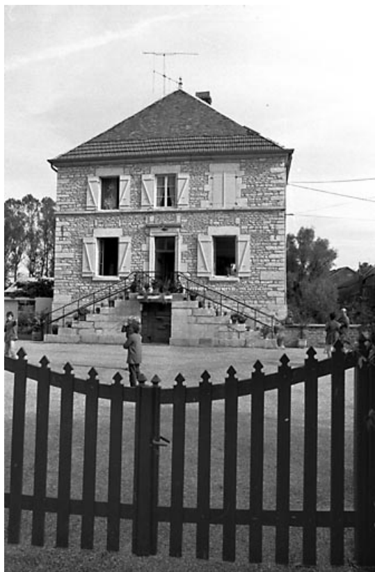
Vue d'ensemble du bâtiment de droite. 70, Charcenne
