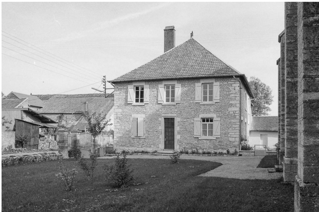
Bâtiment gauche : façade antérieure. 70, Charcenne
