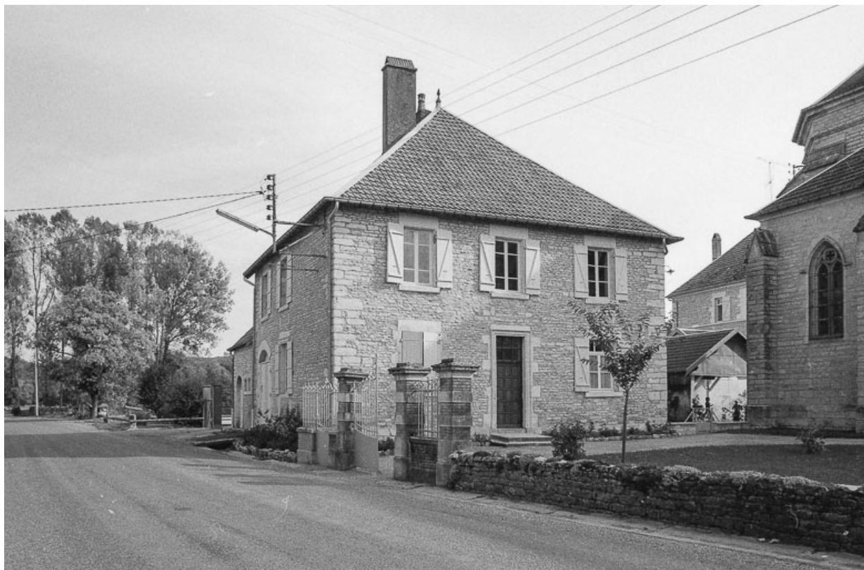
Bâtiment gauche : vue d'ensemble. 70, Charcenne
