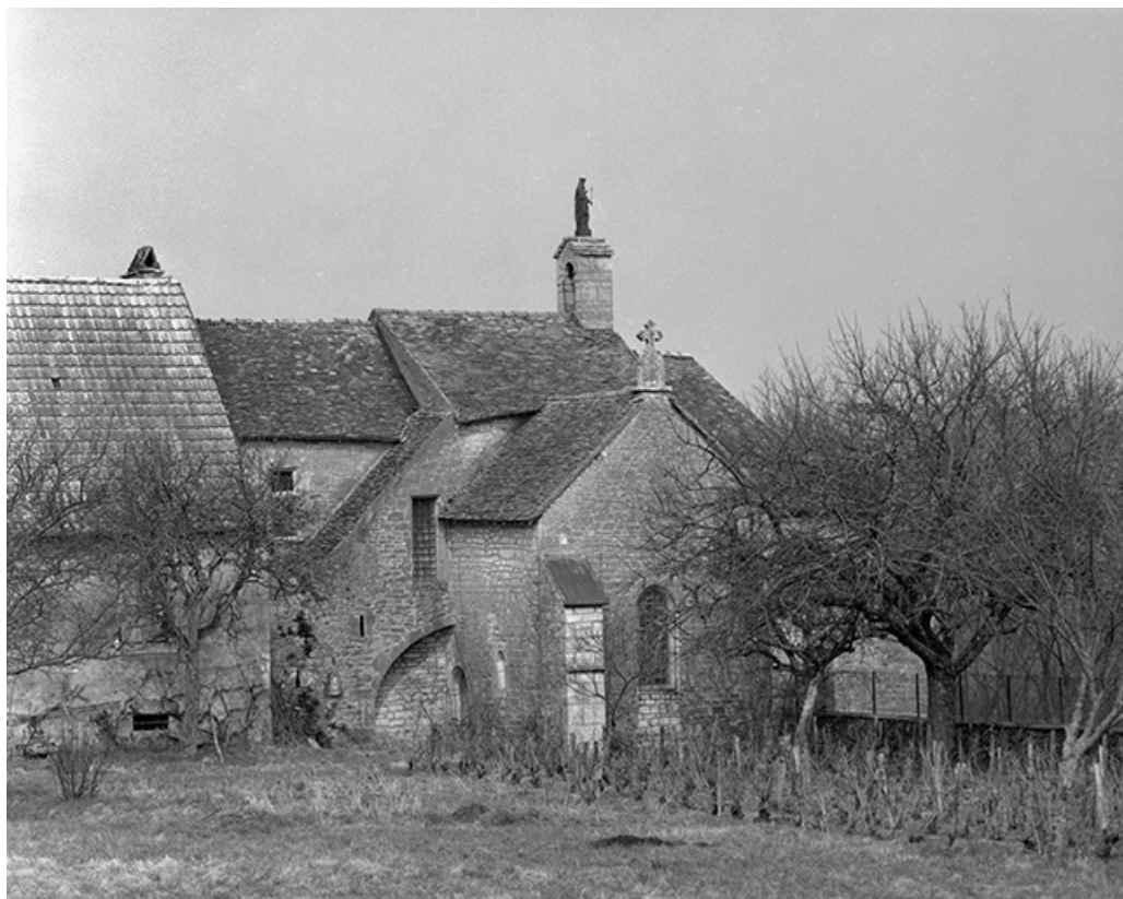
Façade latérale droite.
