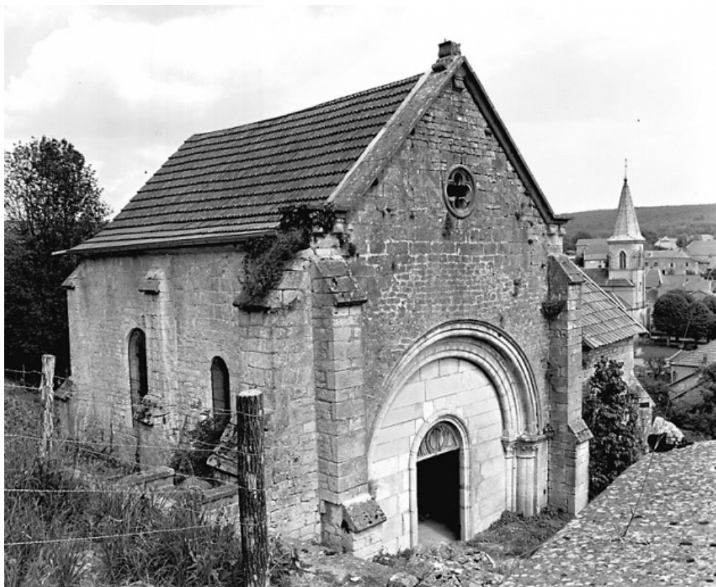
Façades antérieure et latérale gauche.
