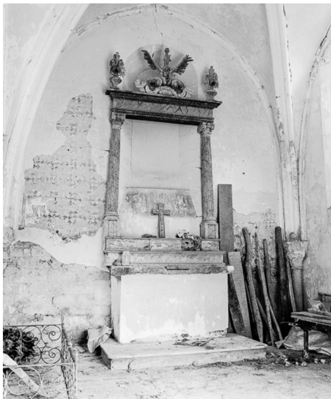
Intérieur : mur postérieur de la chapelle avec reste de retable.
