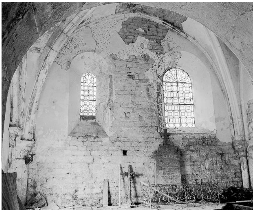
Intérieur : mur latéral gauche.
