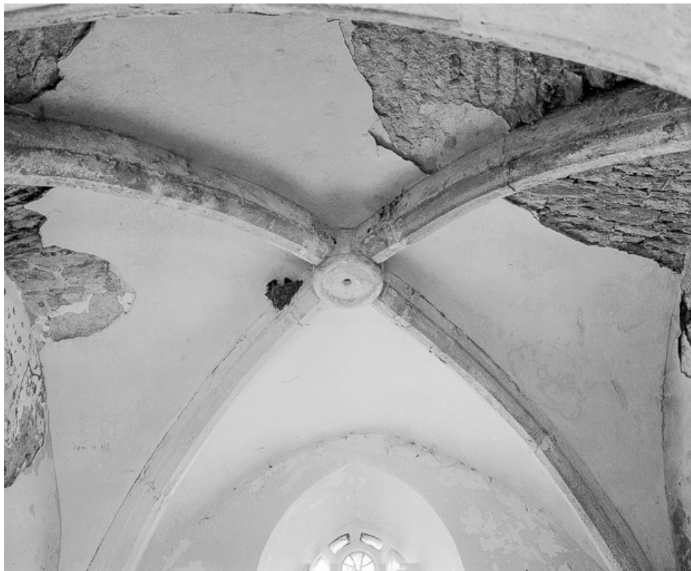
Intérieur : voûte de la chapelle latérale droite.
