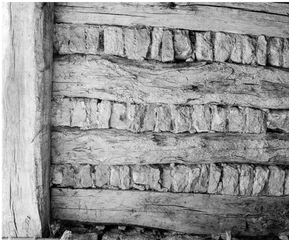
Plafond de la cave : hourdis de pierre.
