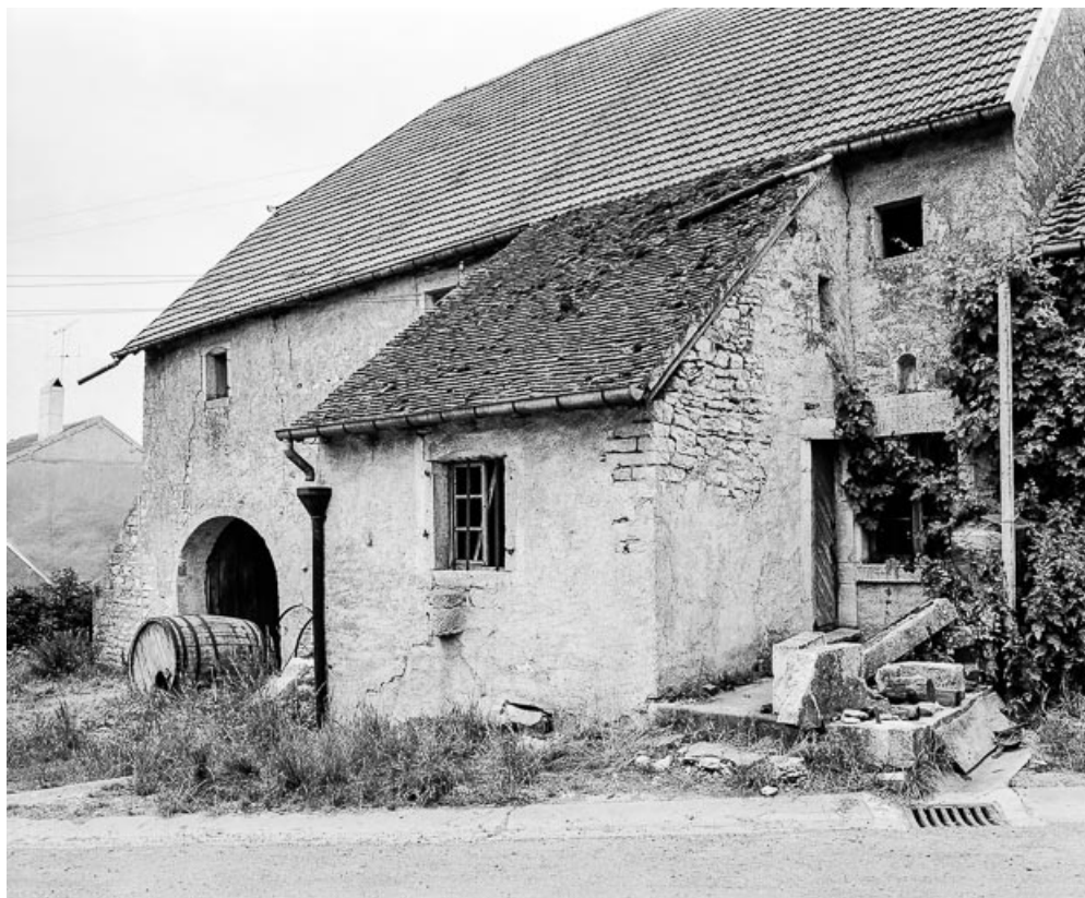
Détail : entrée d'habitation.
