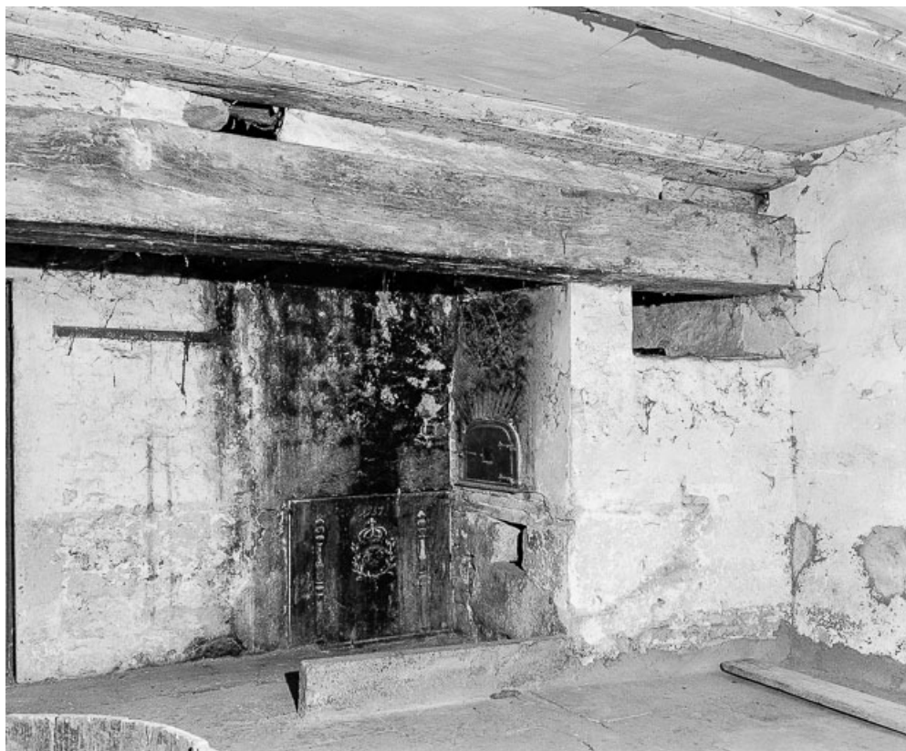
Intérieur : cheminée et four de la cuisine. 70, Charcenne rue de la Vergenne
