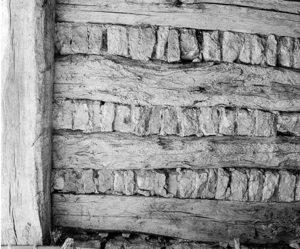
Plafond de la cave : hourdis de pierre.
