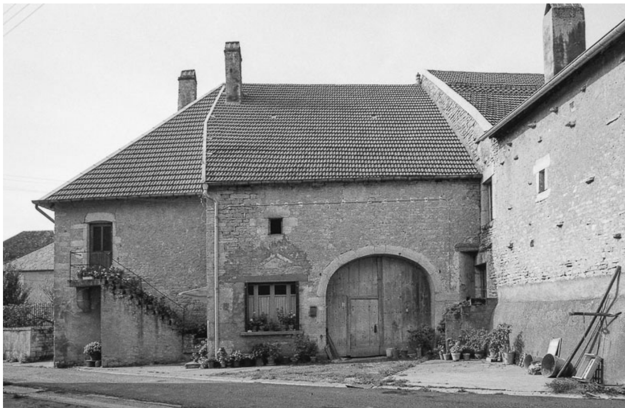
Façade antérieure vue de face.
