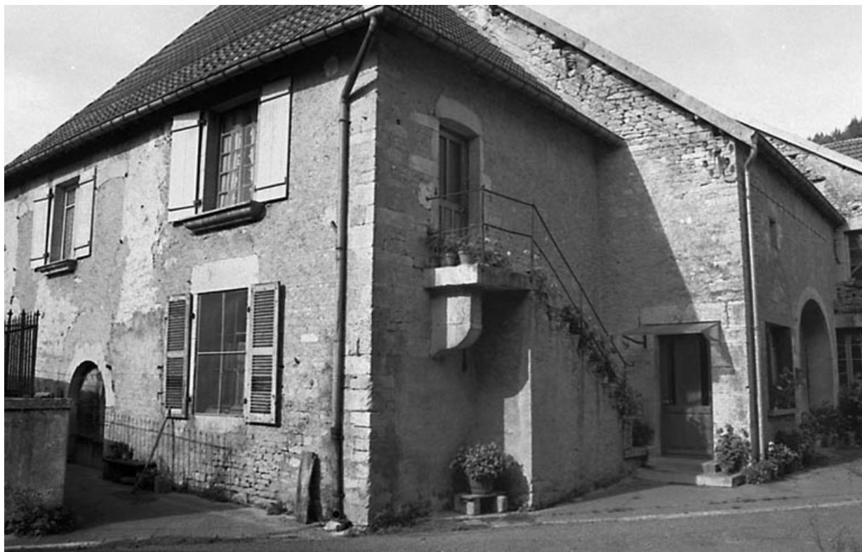
Façades antérieure et latérale gauche. 70, Charcenne
