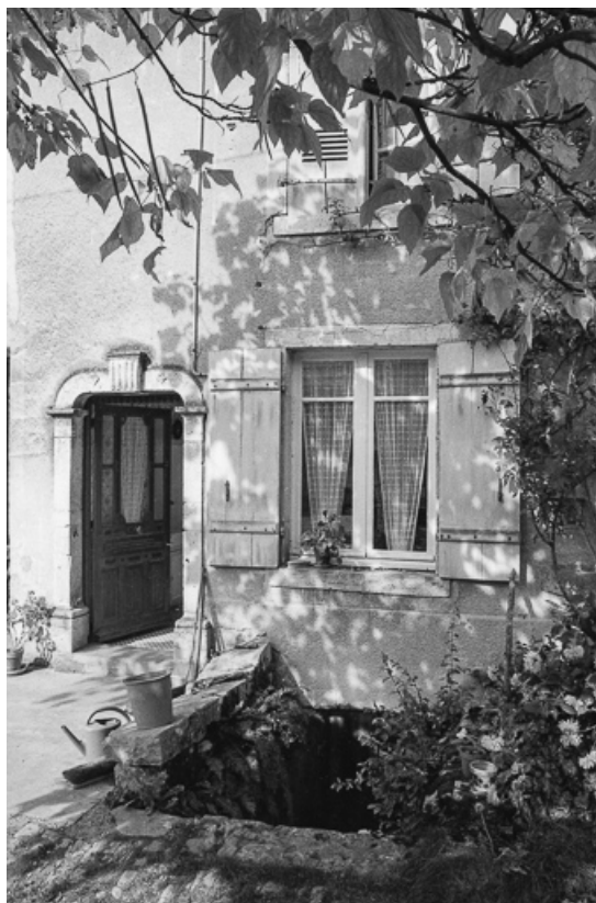
Détail : entrées de cave et d'habitation.
