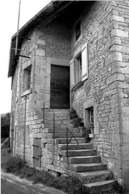
Escalier sur la façade antérieure vu de trois quarts droit.
