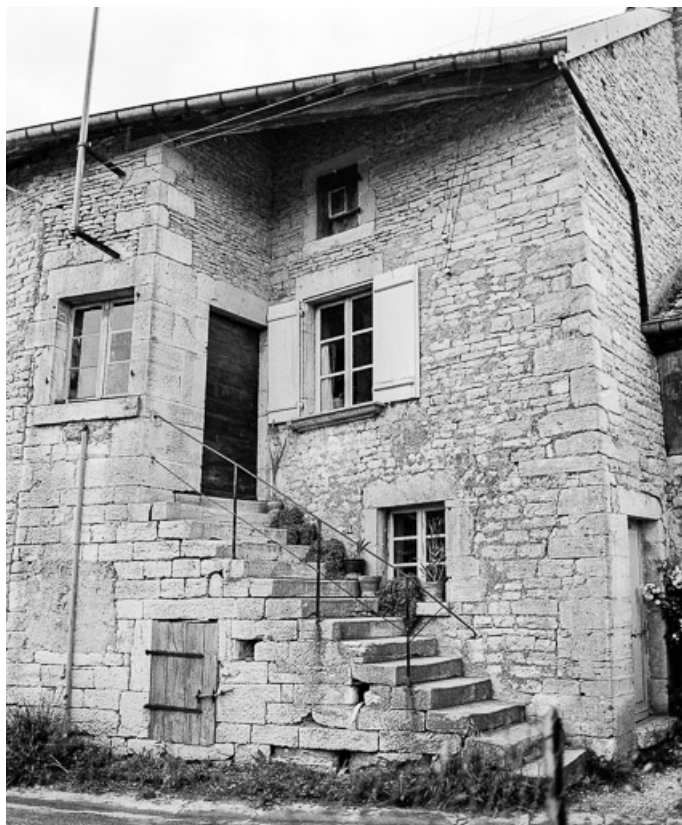
Escalier sur la façade antérieure vu de face.
