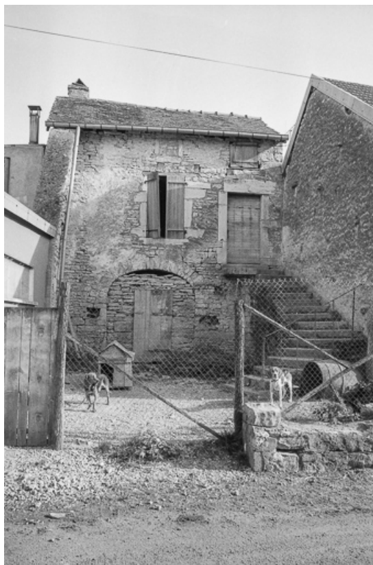
Ferme cadastrée 1958 C3 878 : façade postérieure, sur rue. 70, Charcenne
