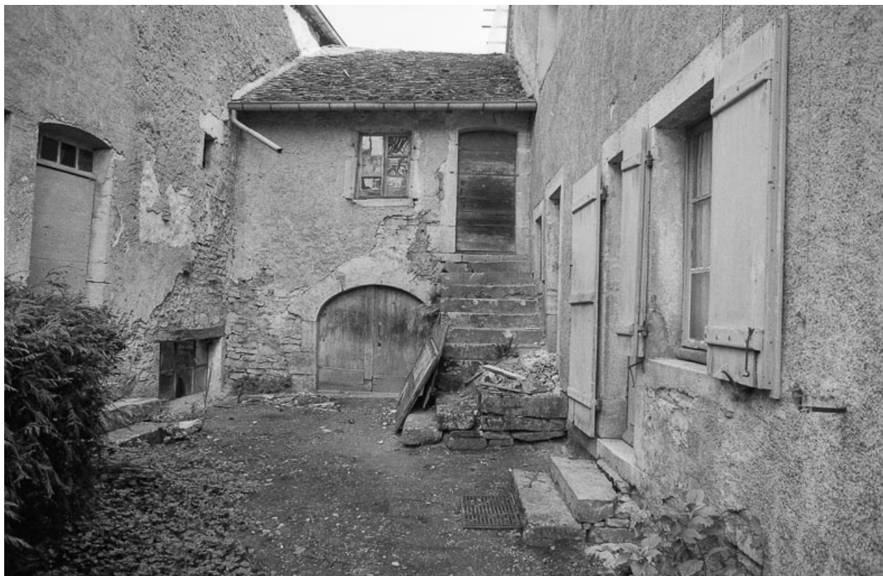
Maison cadastrée 1958 C3 754 : façades sur la cour intérieure. 70, Charcenne
