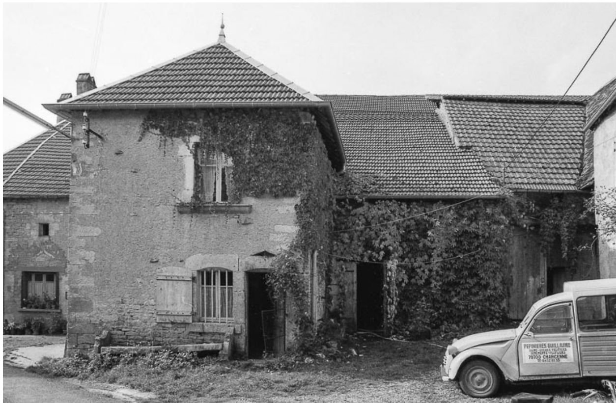
Ferme cadastrée 1958 C3 703 : façade antérieure.
