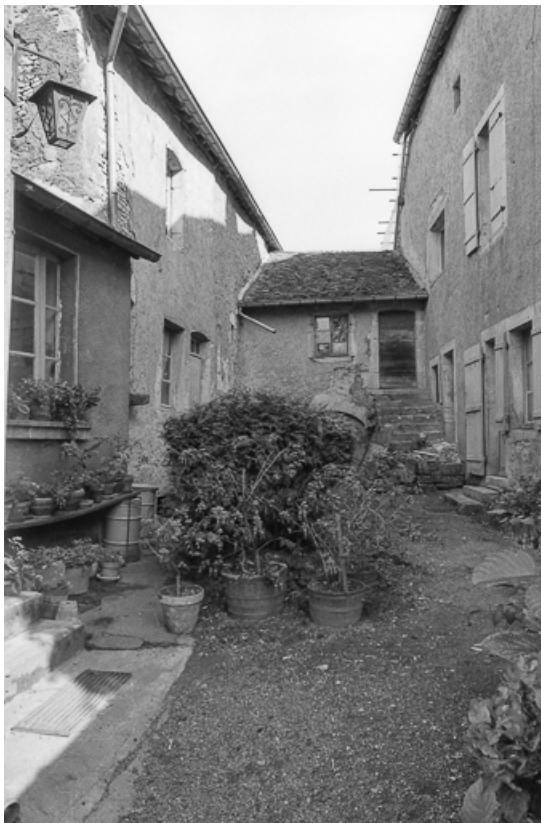
Maison cadastrée 1958 C3 754 : façades sur la cour intérieure. 70, Charcenne
