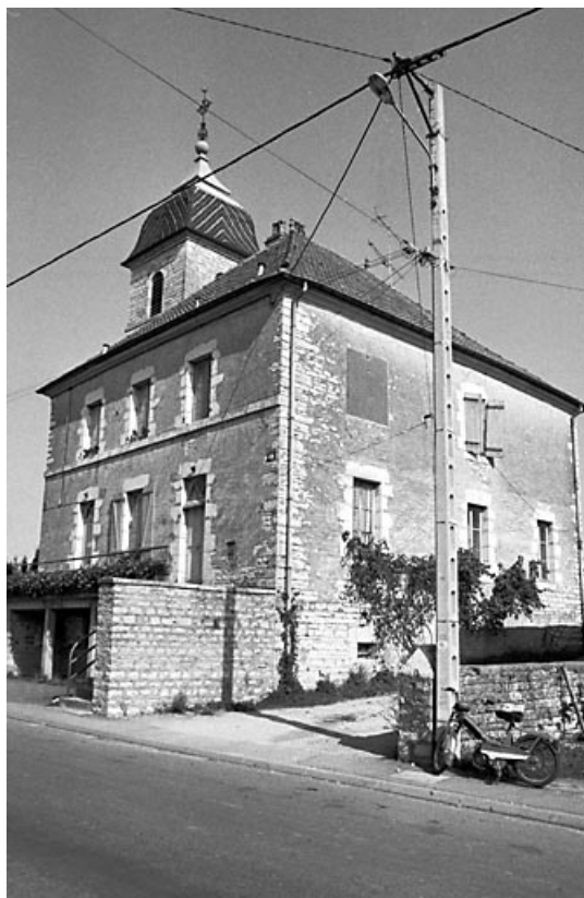
Façades antérieure et latérale droite.
