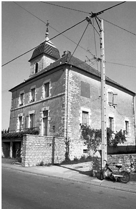
Façades antérieure et latérale droite.
