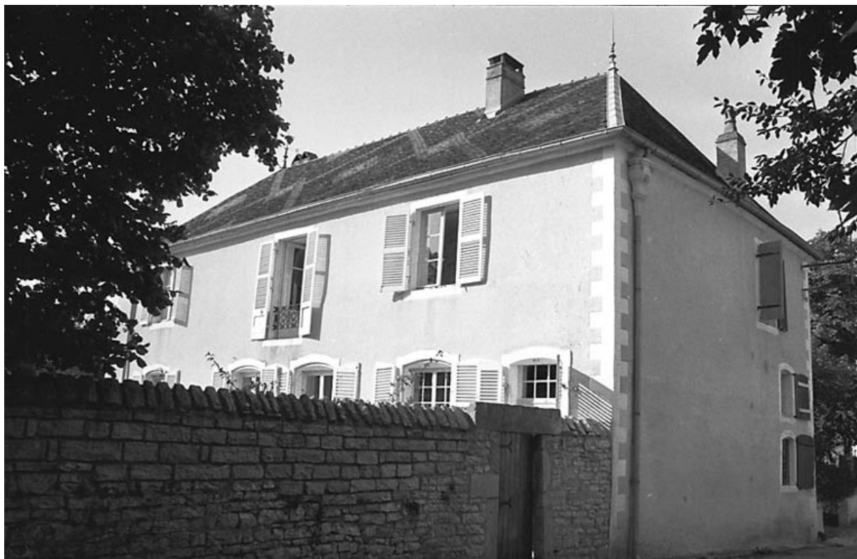
Habitation : façade sur jardin.
