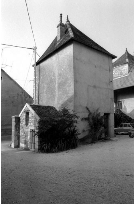
Tour vue depuis la cour.
