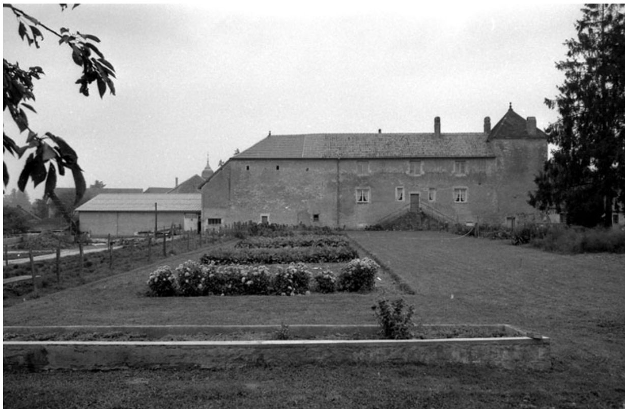
Façade latérale gauche.
