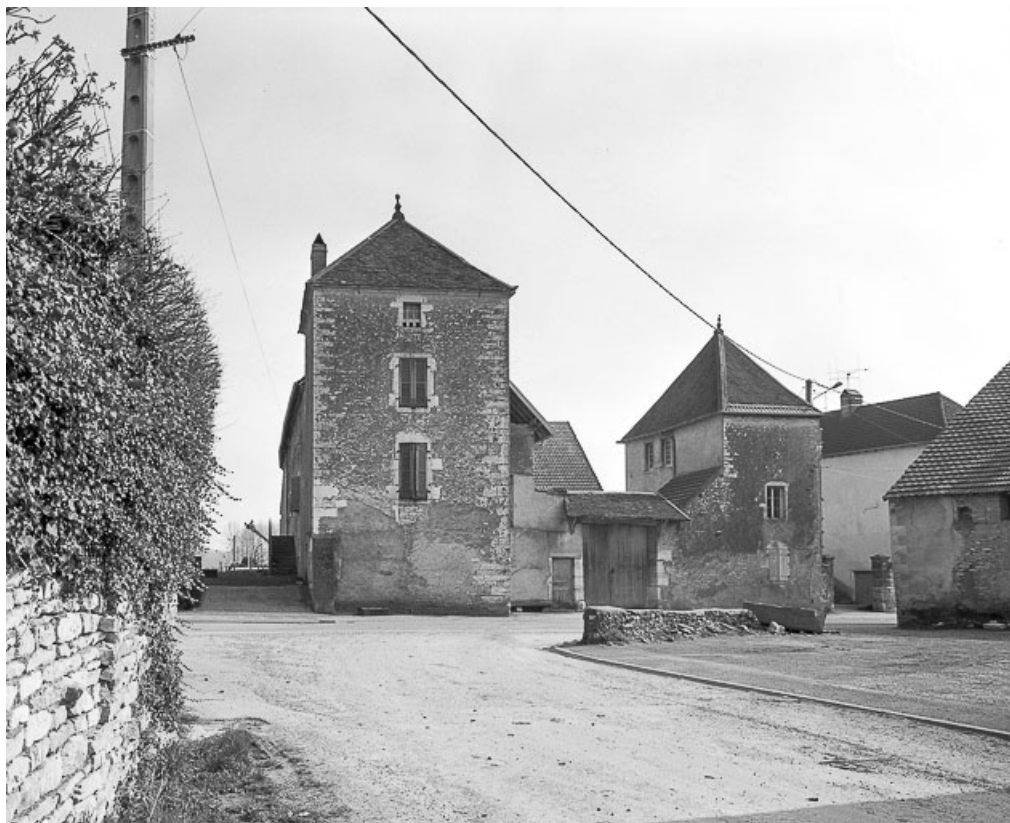
Vue d'ensemble depuis la rue d'Avrigny.
