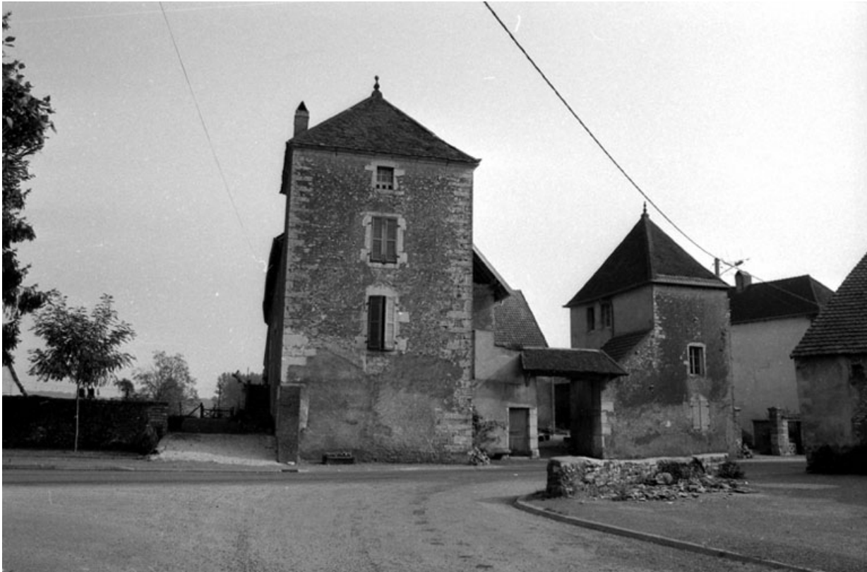
Vue d'ensemble depuis la rue d'Avrigny.
