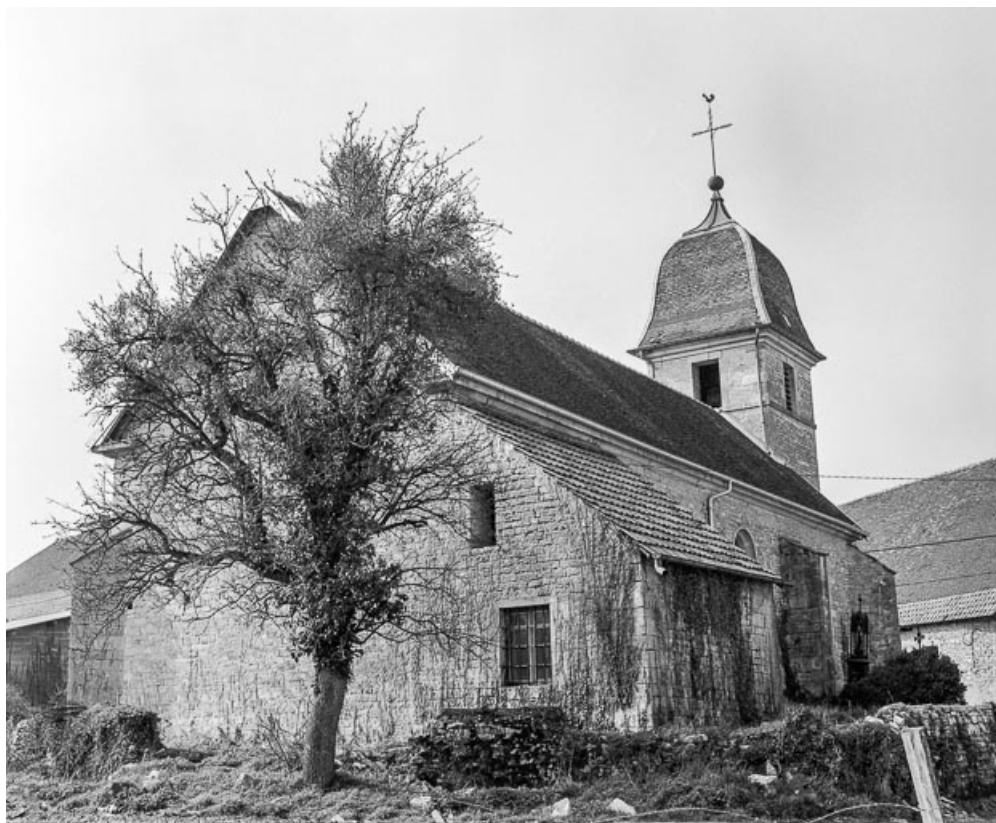
Façades postérieure et latérale gauche.
