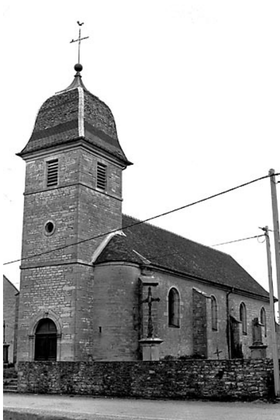
Façades antérieure et latérale droite.
