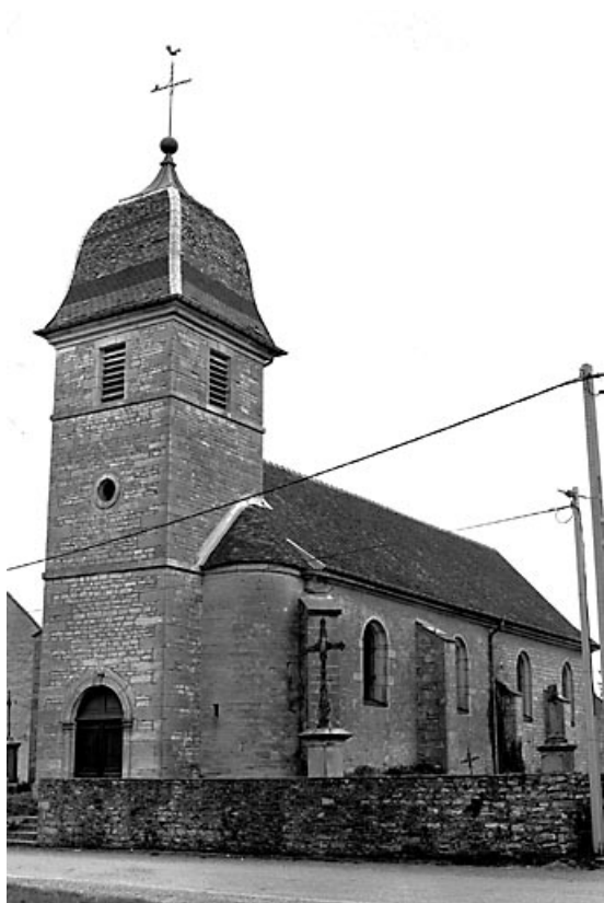
Façades antérieure et latérale droite.
