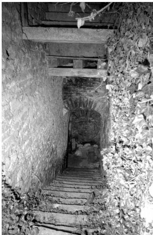
Partie habitation : escalier menant à la cave.
