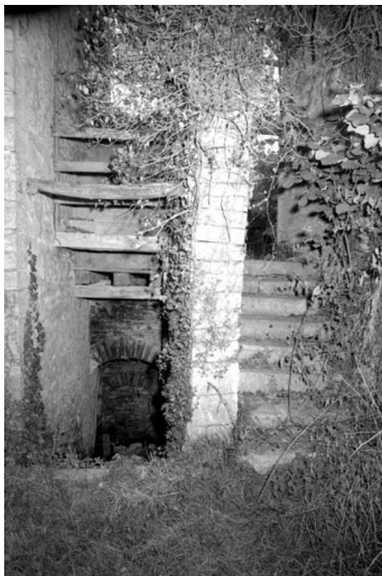
Partie habitation : escaliers menant à la cave et au premier étage de l'habitation.
