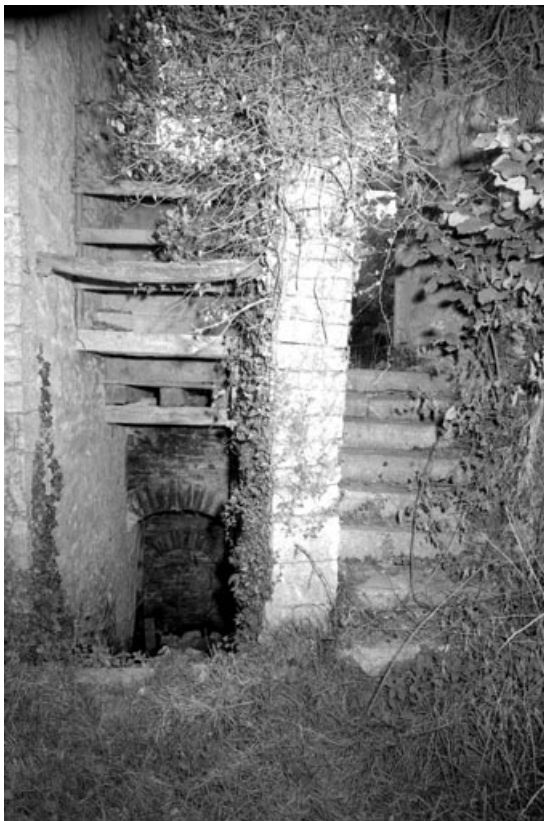
Partie habitation : escaliers menant à la cave et au premier étage de l'habitation. 70, Bonboillon impasse des Champs du Four
