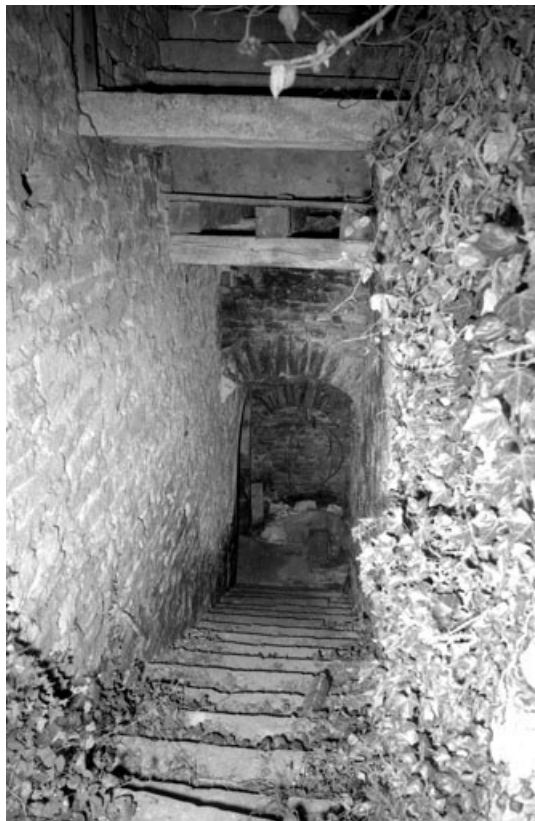
Partie habitation : escalier menant à la cave.
