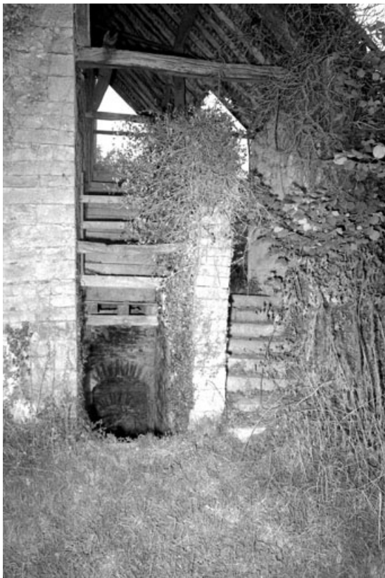
Partie habitation : escaliers menant à la cave et au premier étage.
