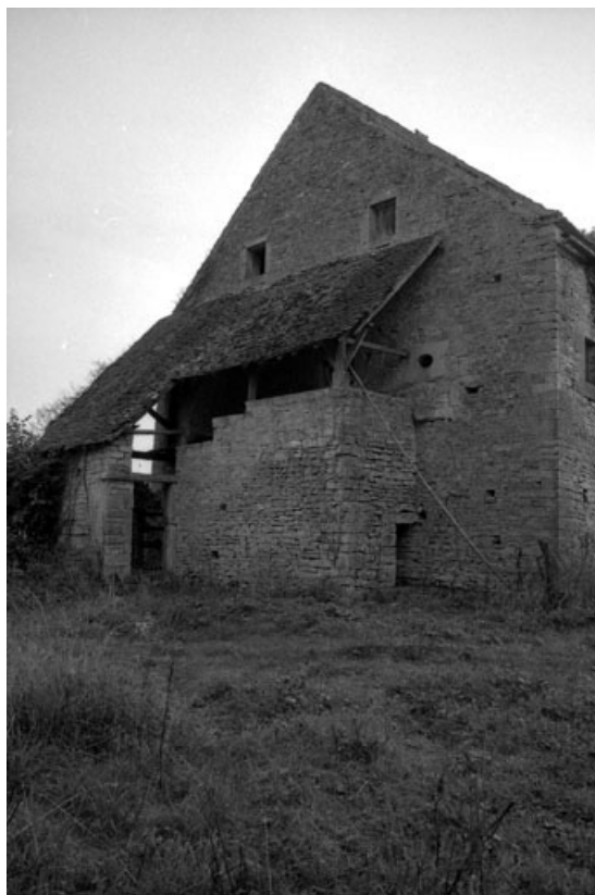
Façade latérale droite.
