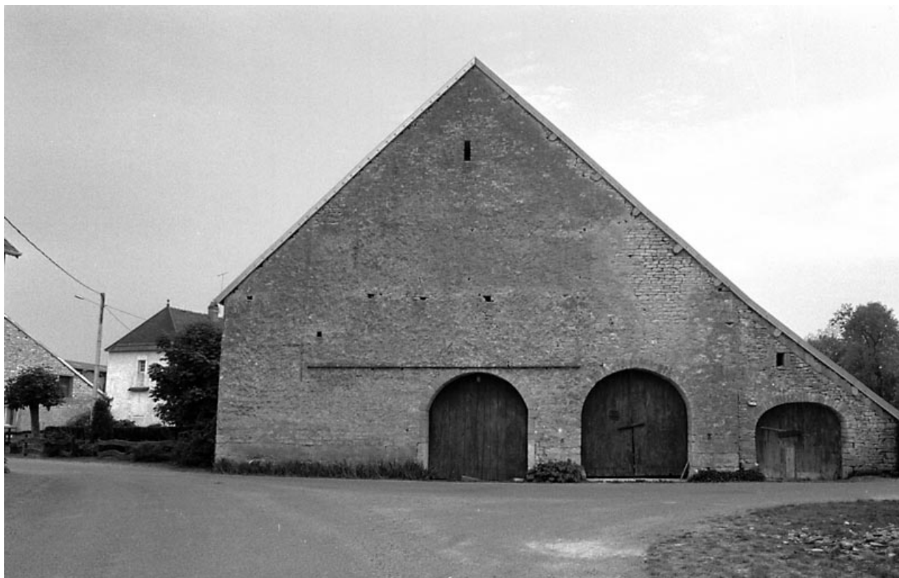
Façade latérale droite.
