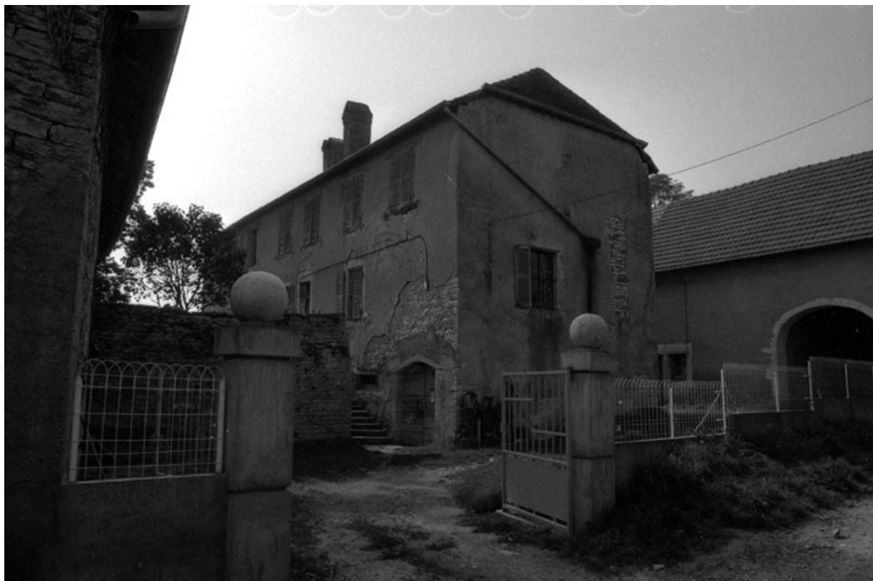
Maison d'habitation : façades antérieure et latérale droite.
