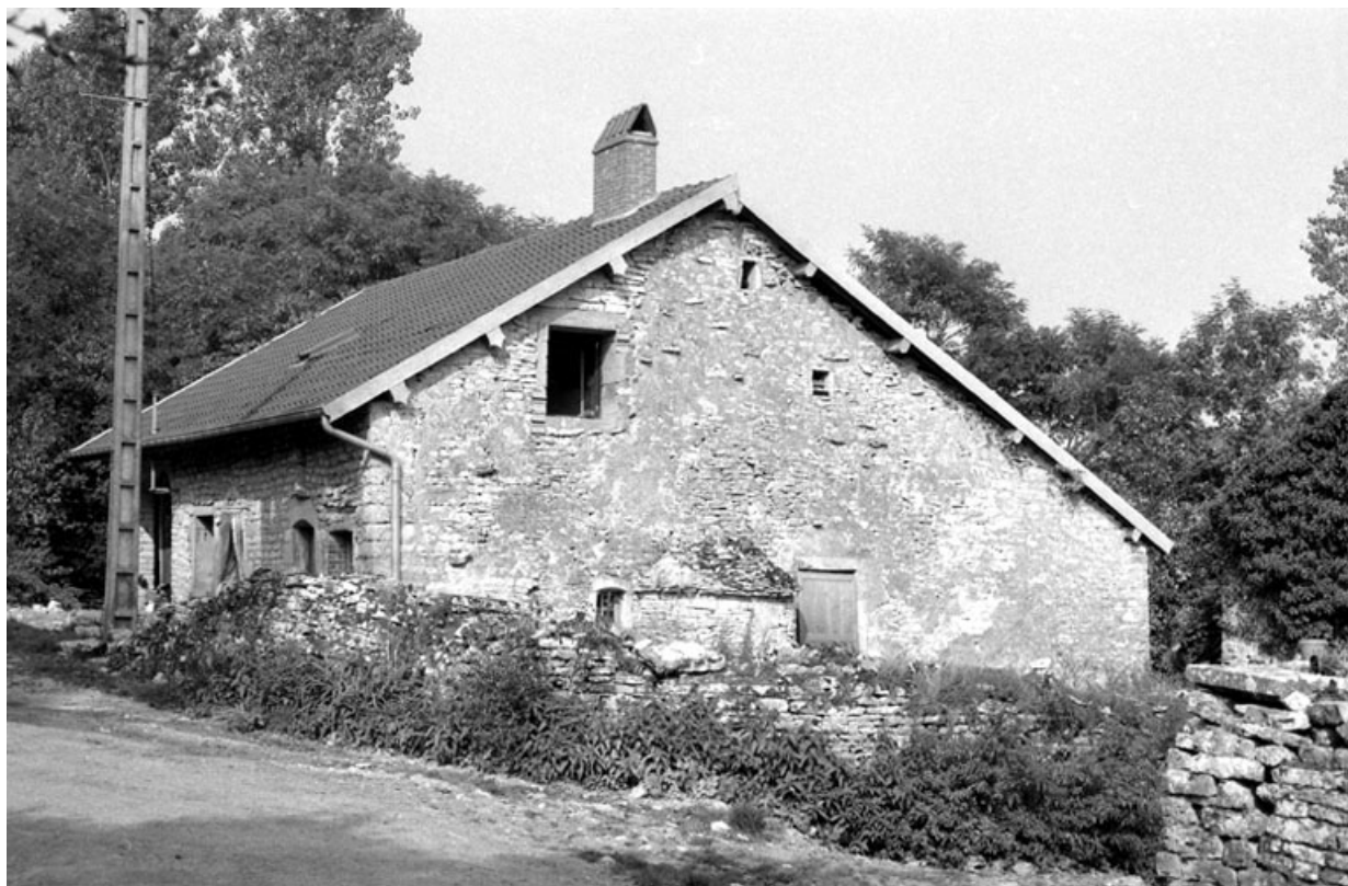
Façade latérale droite. 70, Beaumotte-lès-Pin
