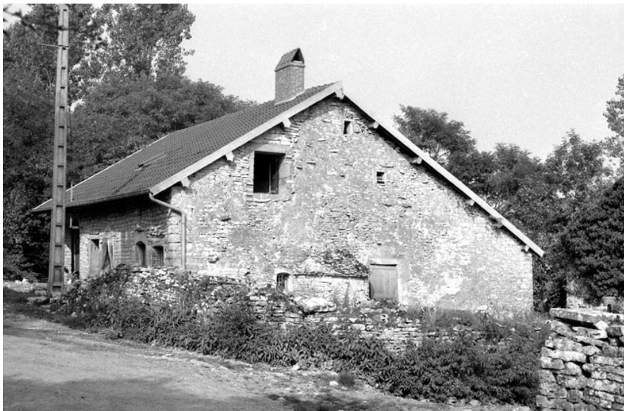
Façade latérale droite.
