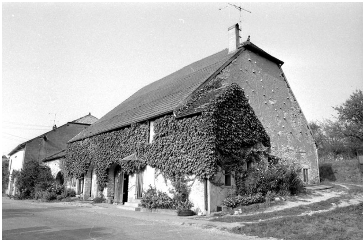
Façades antérieure et latérale droite.
