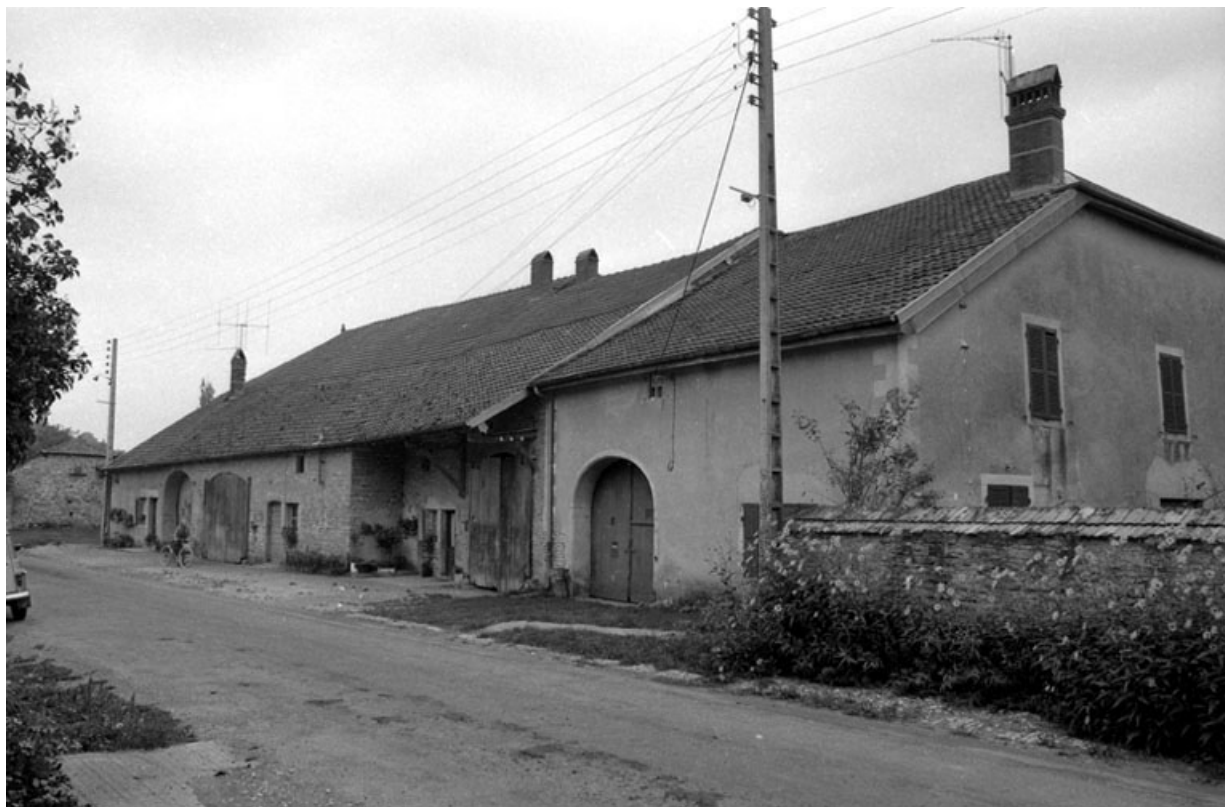
Façades antérieure et latérale droite. 70, Beaumotte-lès-Pin
