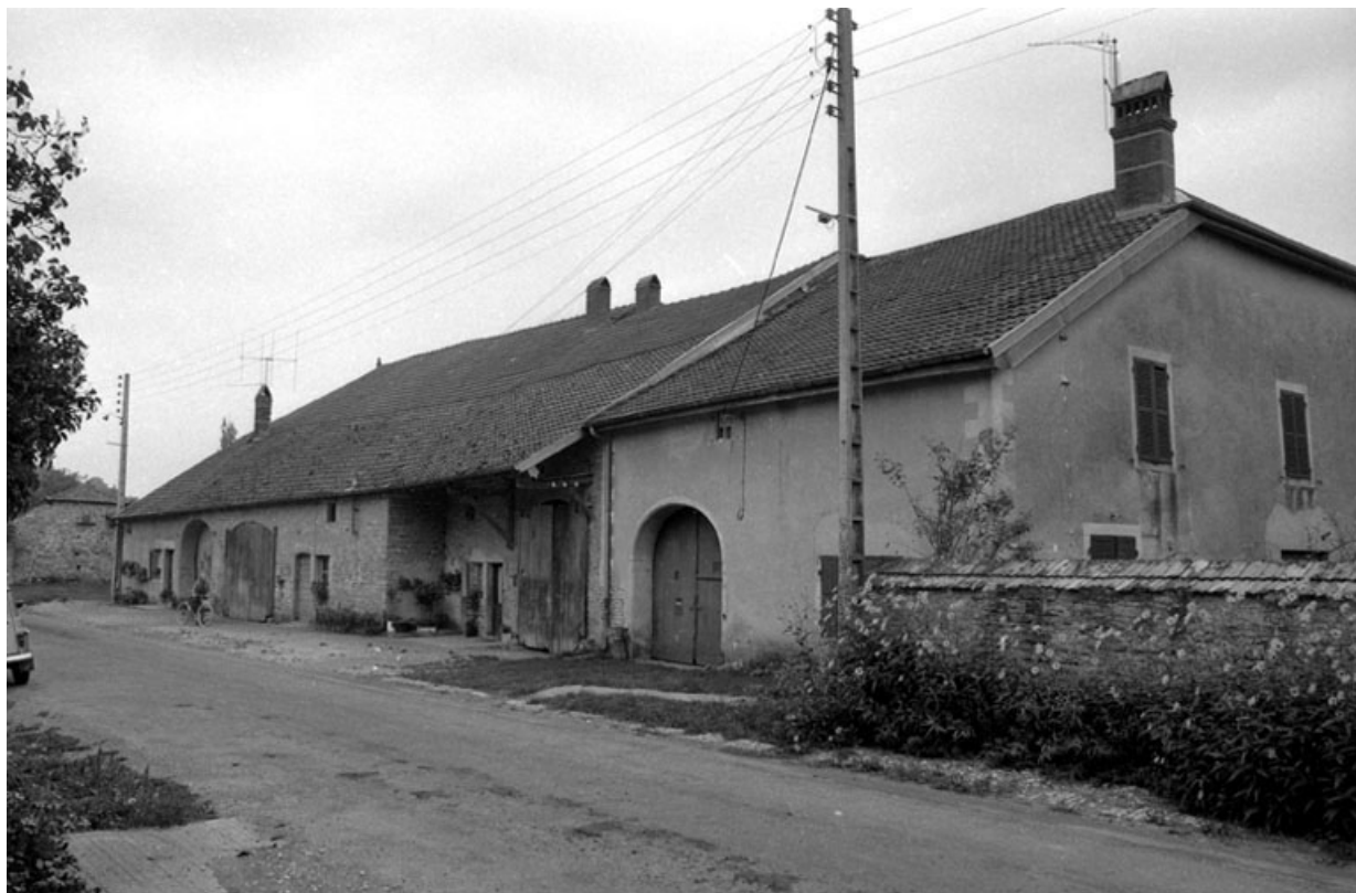
Façades antérieure et latérale droite. 70, Beaumotte-lès-Pin
