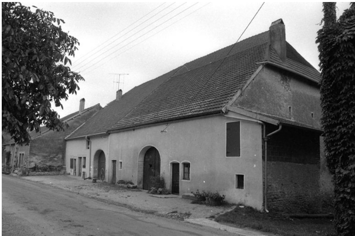
Ferme situées 15 et 17 Grande Rue : vue d'ensemble. 70, Beaumotte-lès-Pin
