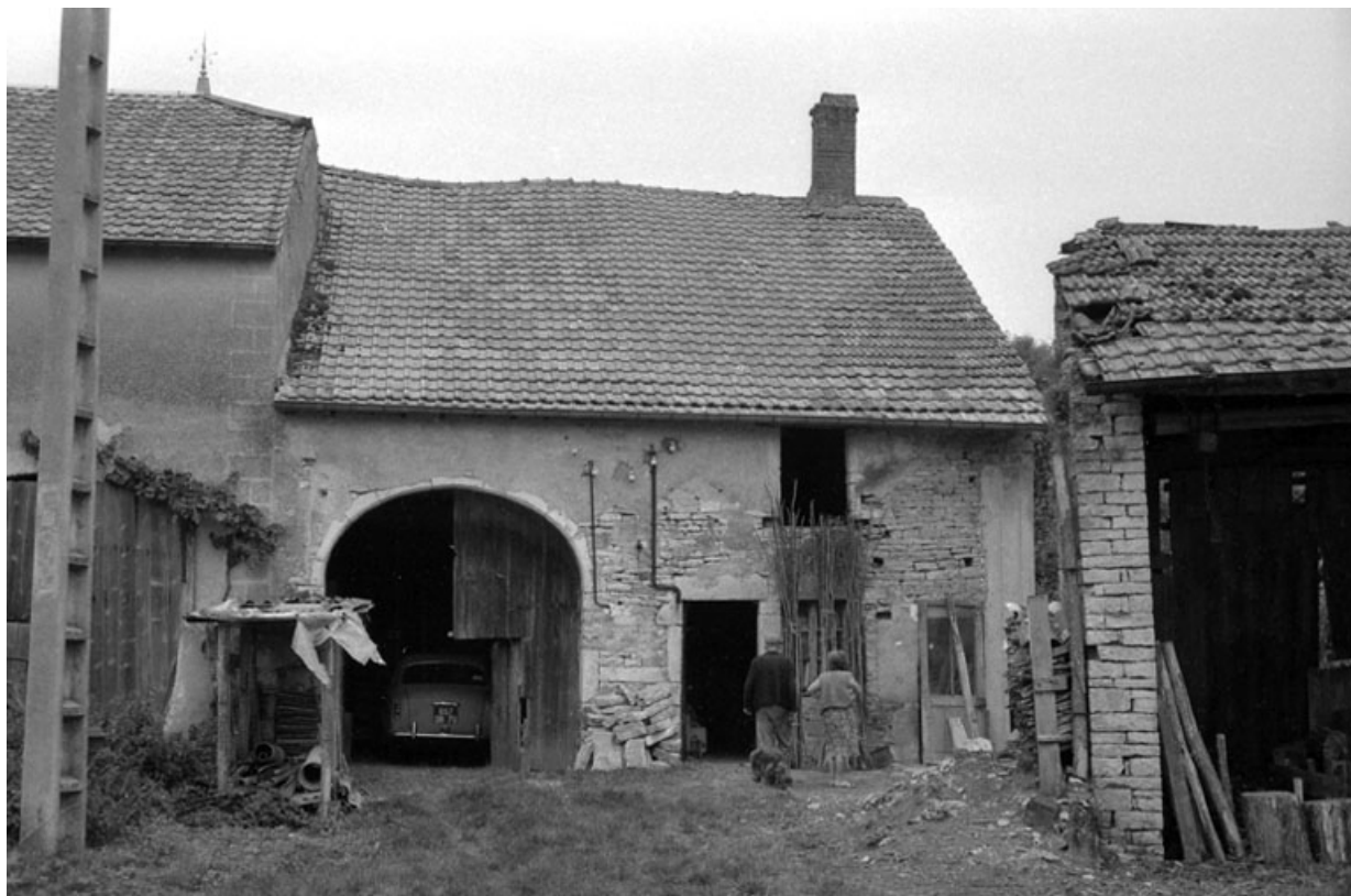
Ferme cadastrée 1966 ZD 169, située Grande Rue : façade antérieure. 70, Beaumotte-lès-Pin
