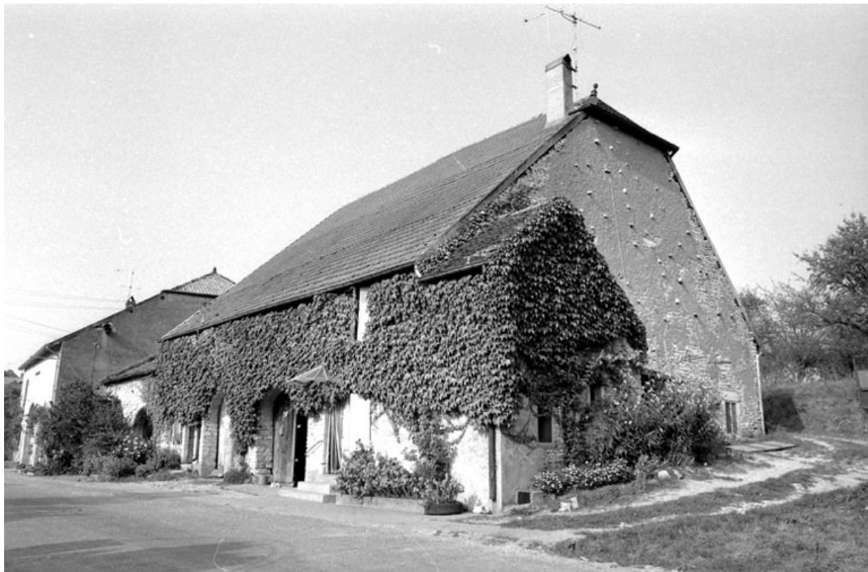
Façades antérieure et latérale droite.
