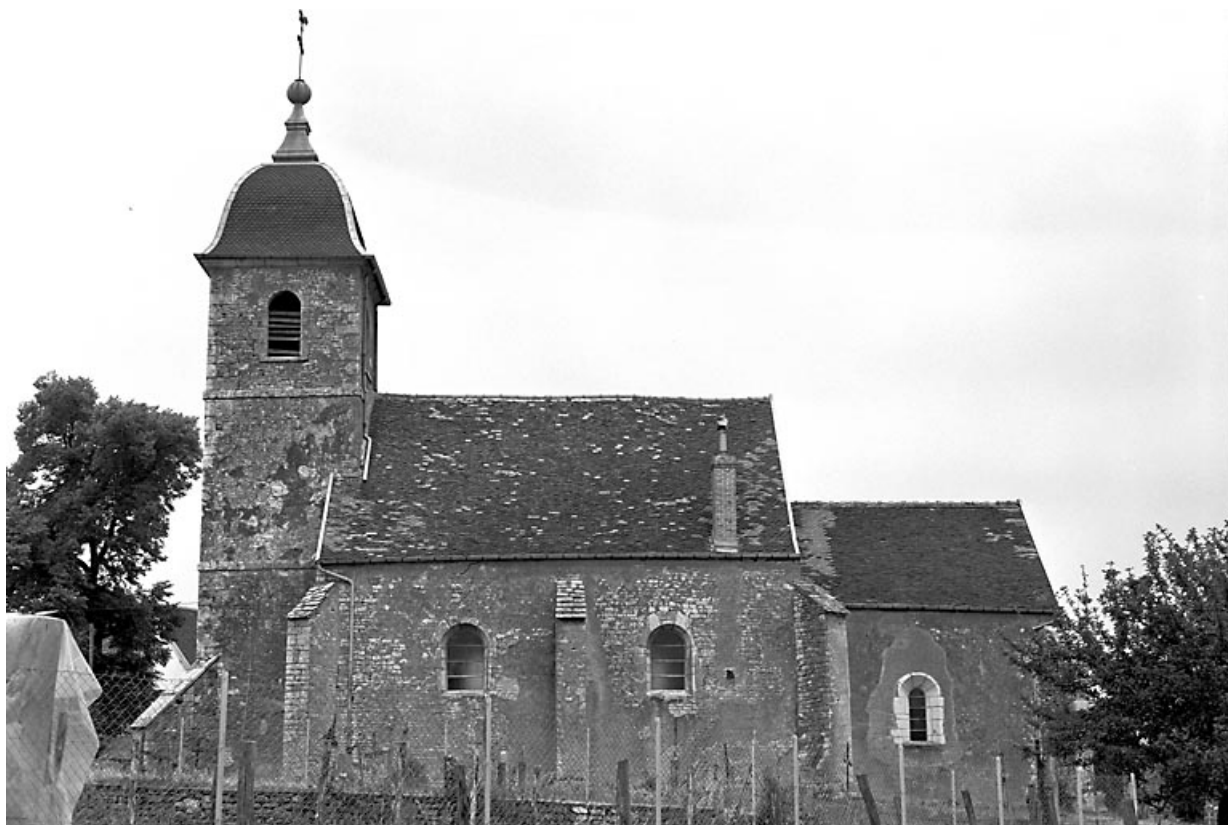
Façade latérale droite.
