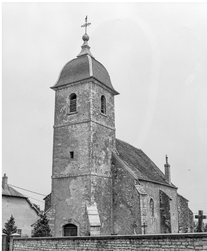
Façade antérieure et face latérale droite.
