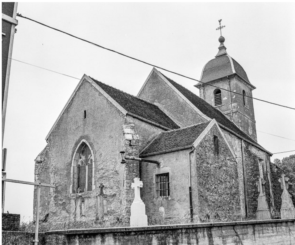
Façades postérieure et latérale gauche.
