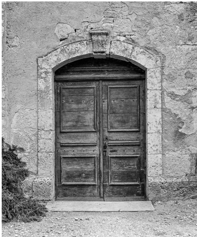
Façade antérieure : détail du portail d'entrée.
