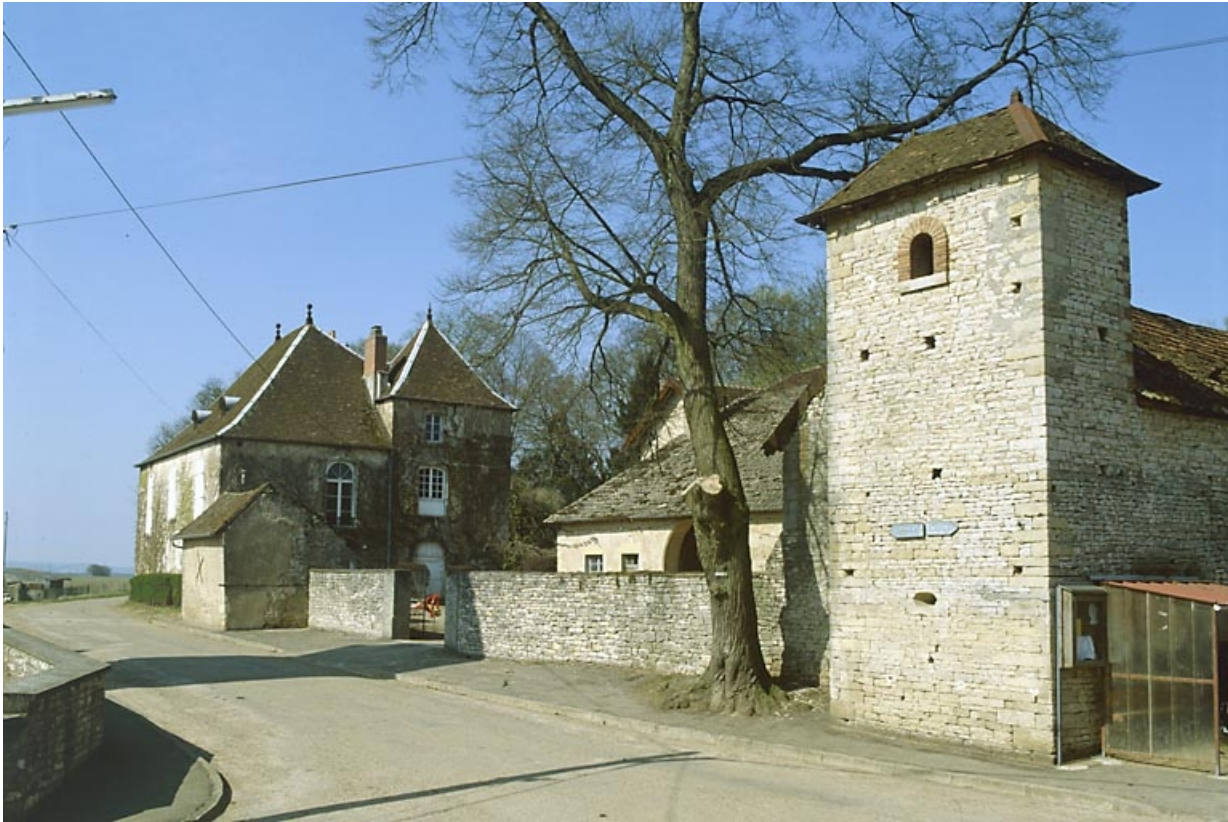
Vue d'ensemble depuis la rue.
