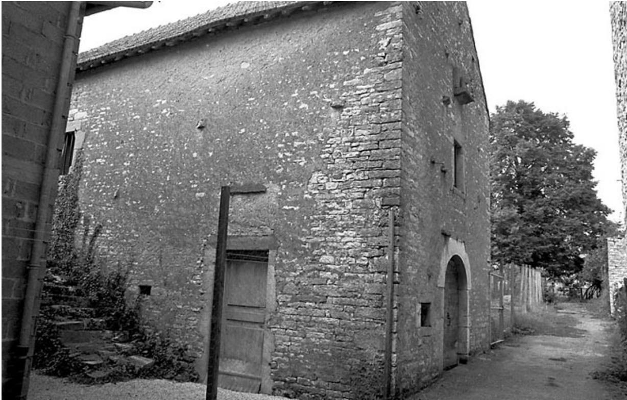
Façades antérieure et latérale droite. 70, Bay
