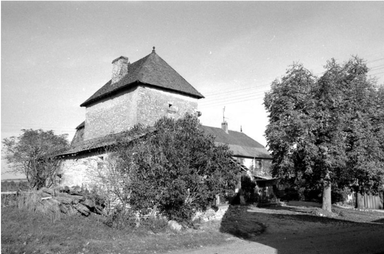
Partie habitation : face latérale gauche.
