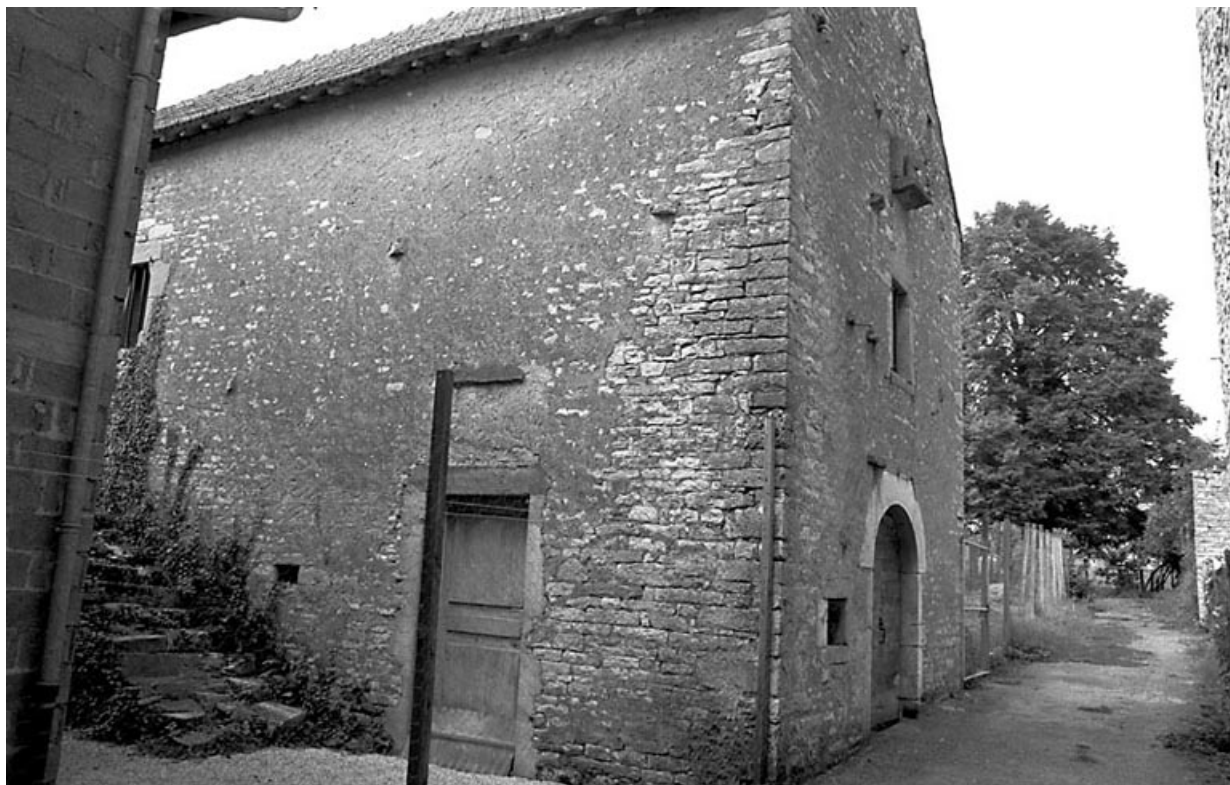
Façades antérieure et latérale droite.
