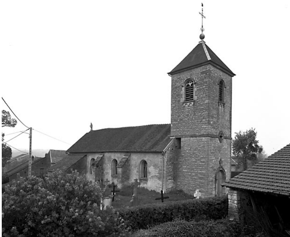
Extérieur : clocher et façade latérale gauche.
