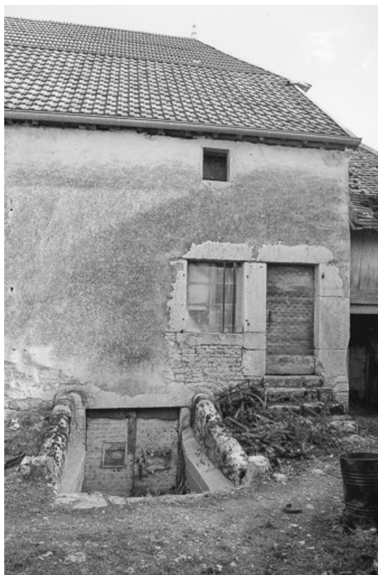
Façade antérieure : entrée de la cave et porte d'entrée de l'habitation.
