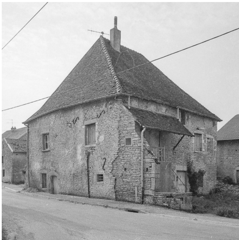
Maison cadastrée 1941 B2 219 : façades sur rue et latérale droite.
