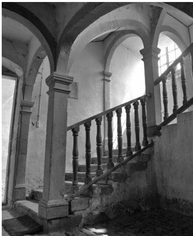
Escalier intérieur : première volée.
