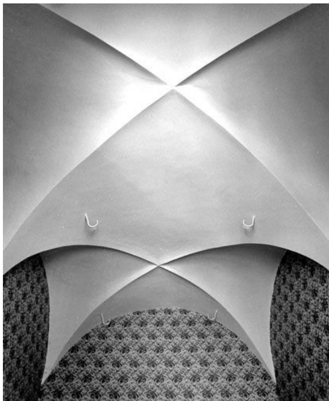
La voûte du poêle.
