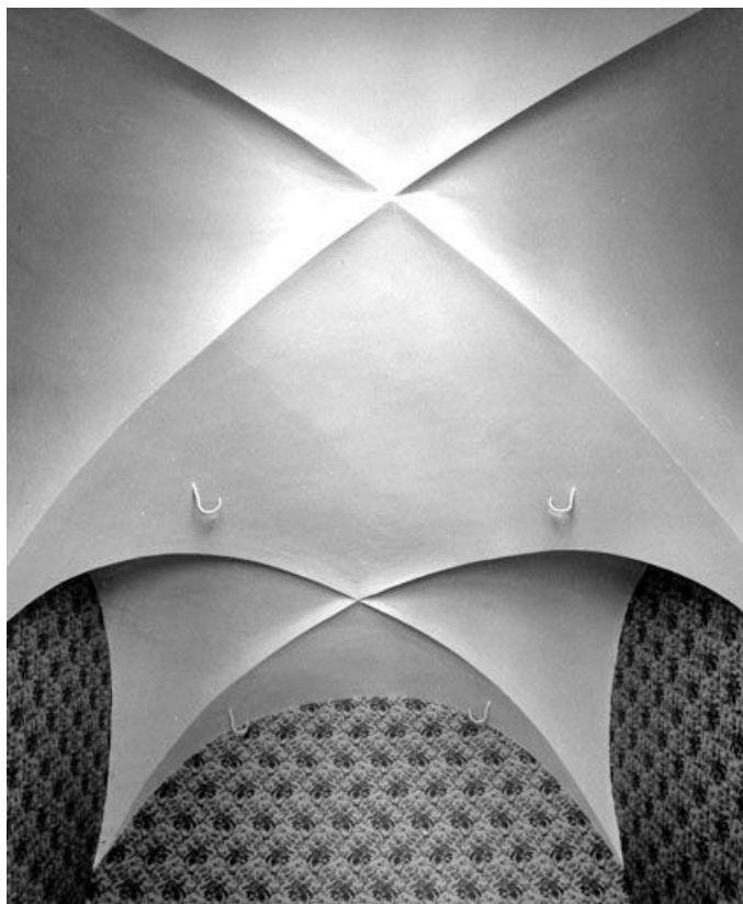
La voûte du poêle.
