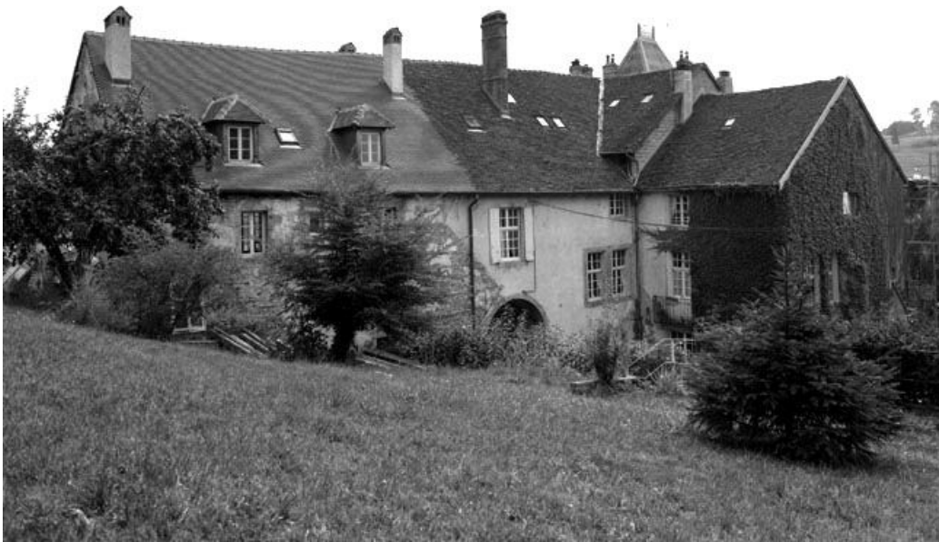
Façade postérieure : vue de trois quarts droit.
