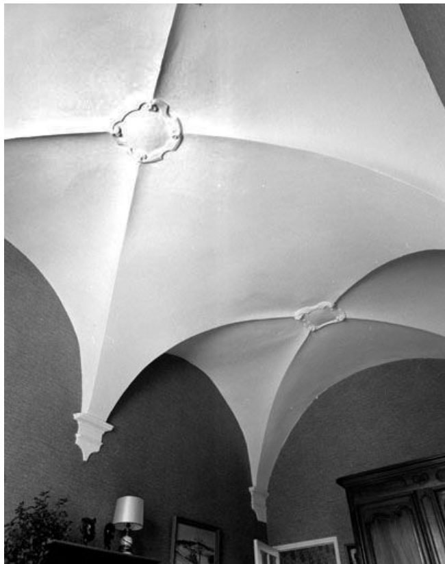
La voûte de la chapelle.
