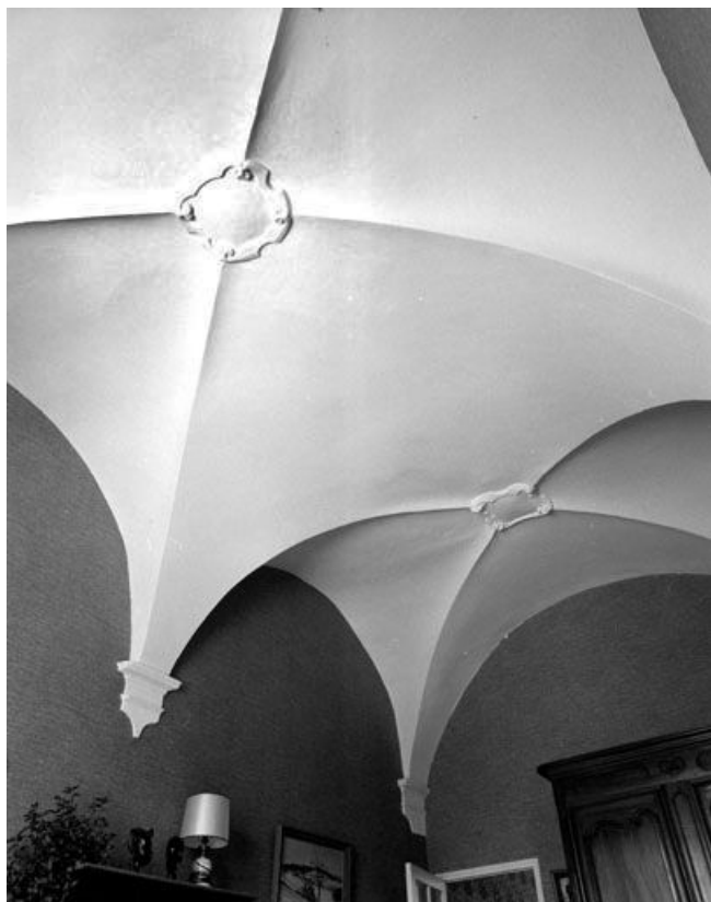
La voûte de la chapelle.
