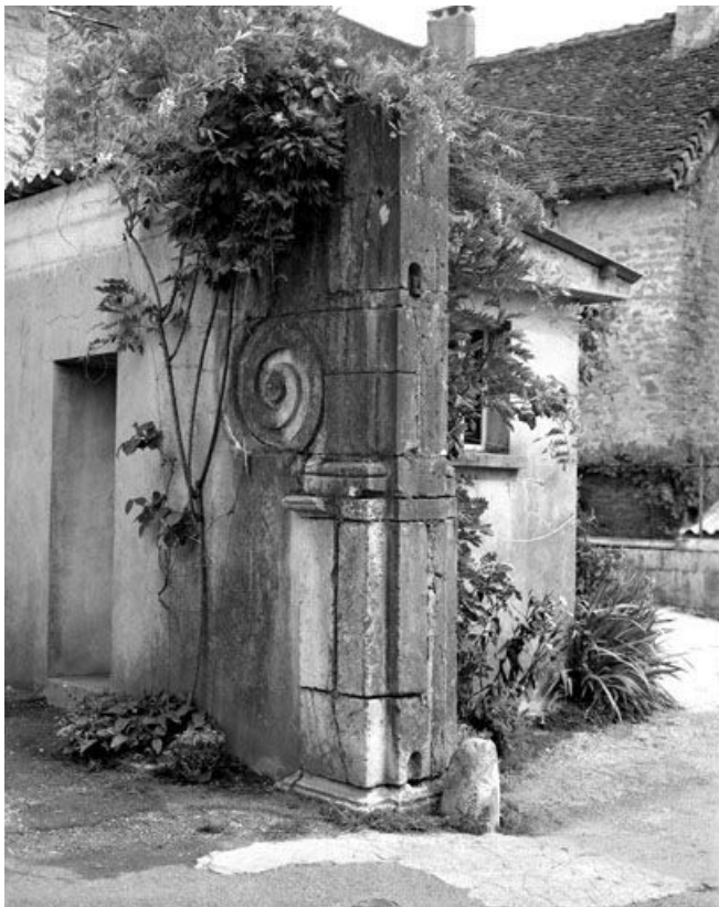
Pilier droit du portail d'entrée de la cour.
