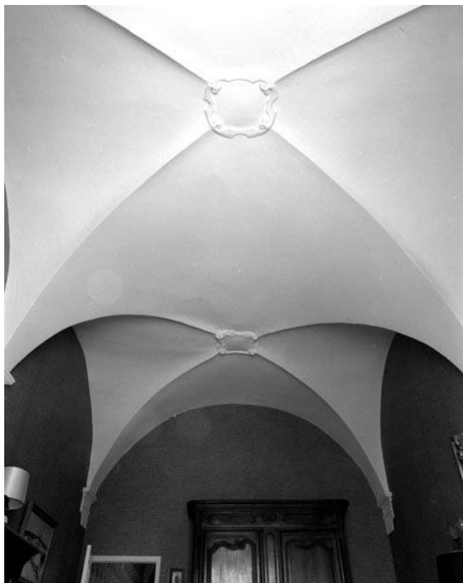
La voûte de la chapelle.
