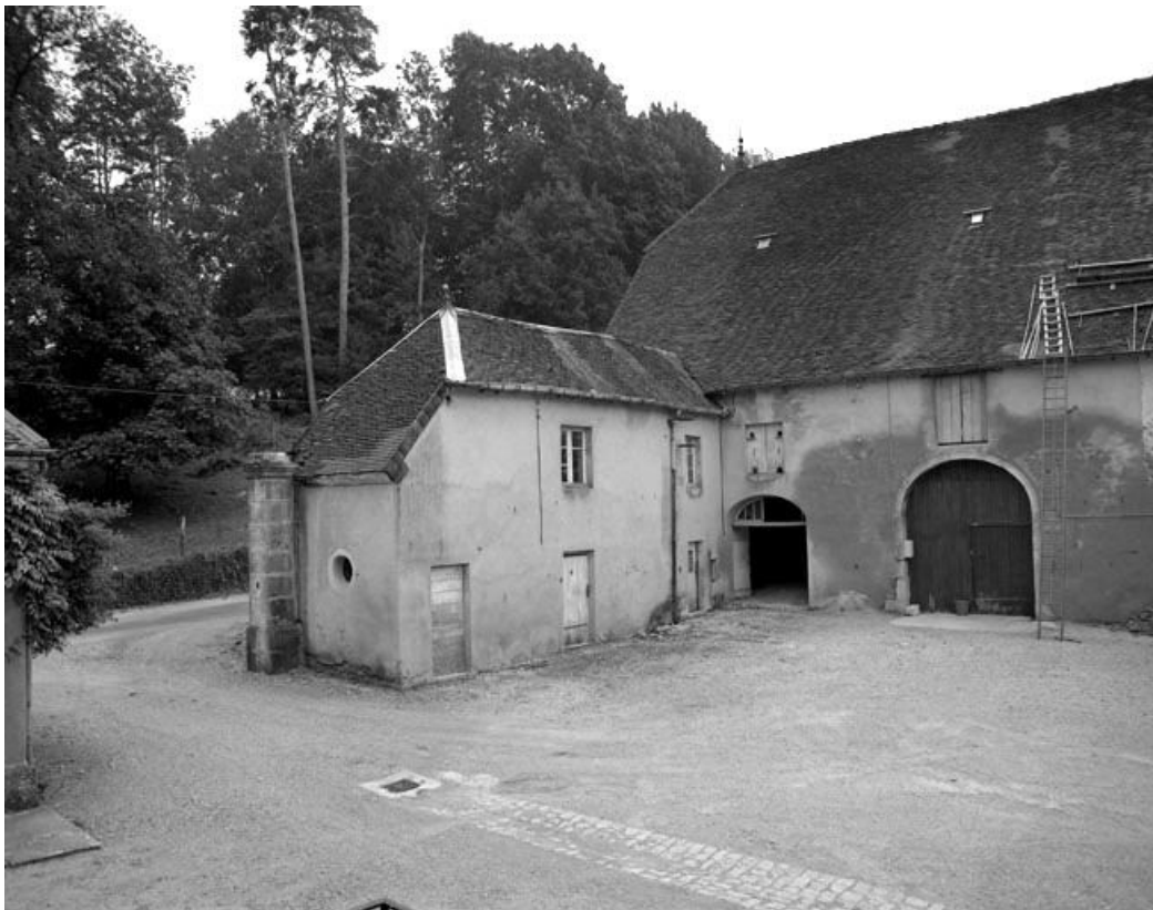
Les parties agricoles, partie gauche : élévation sur la cour.
