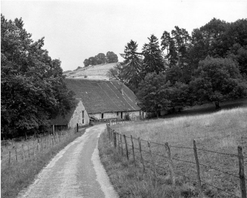
Les parties agricoles vues depuis l'ouest.
