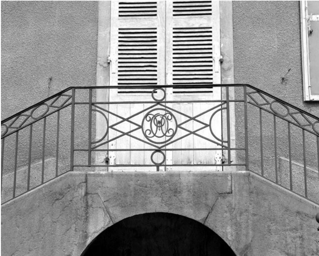
Façade antérieure du logis : détail du perron.
