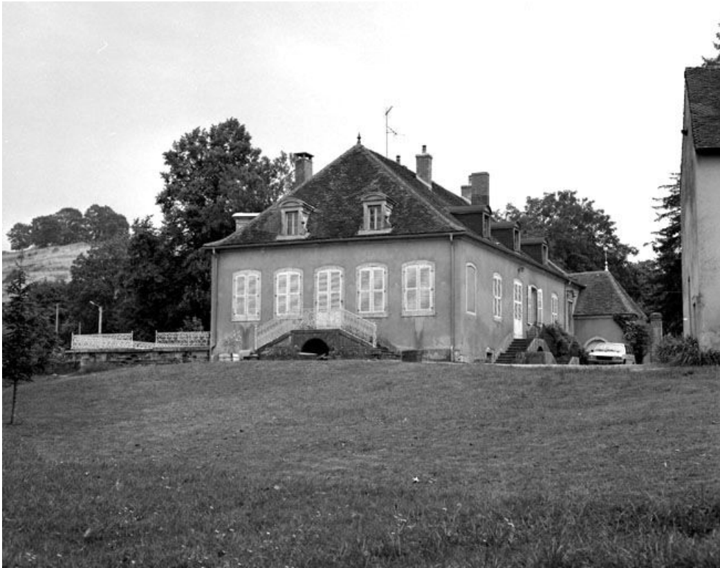
Façade droite du logis.
