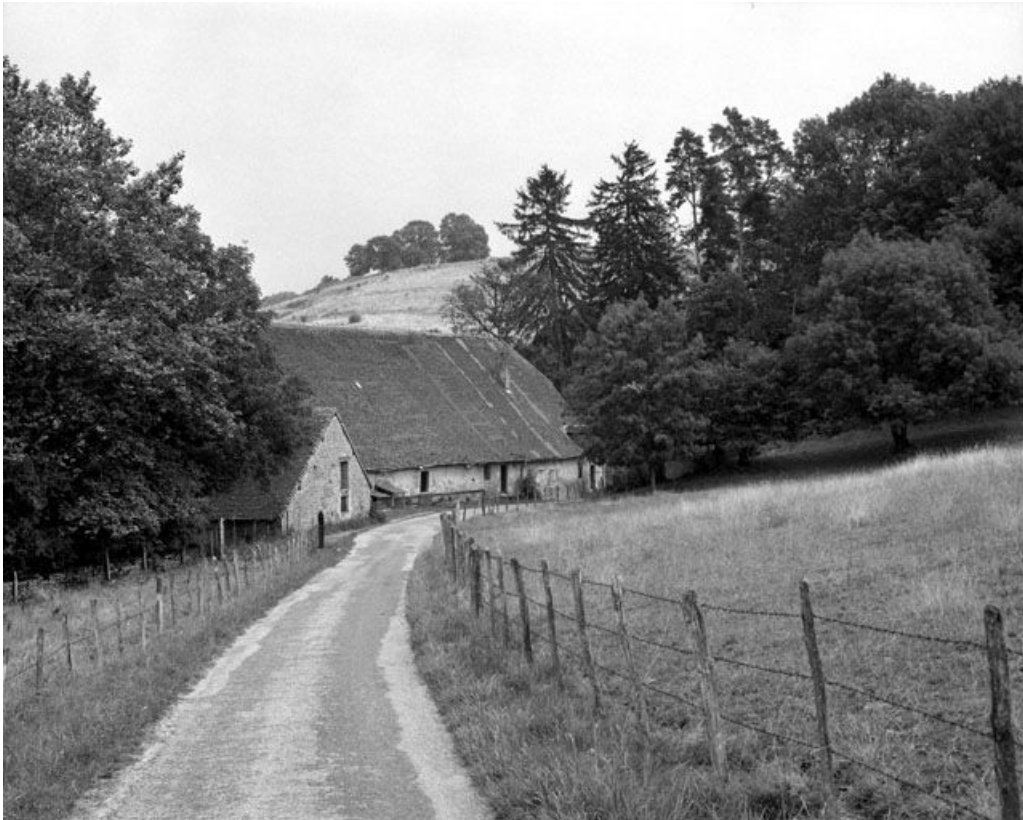
Les parties agricoles vues depuis l'ouest.
