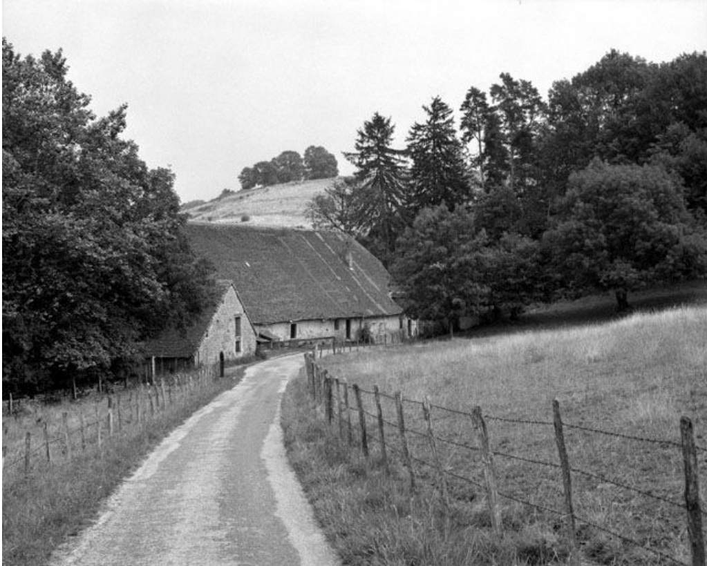
Les parties agricoles vues depuis l'ouest.
