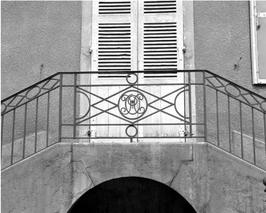
Façade antérieure du logis : détail du perron.
