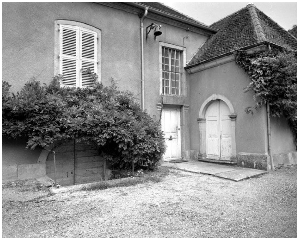
Façade antérieure du logis : partie droite.
