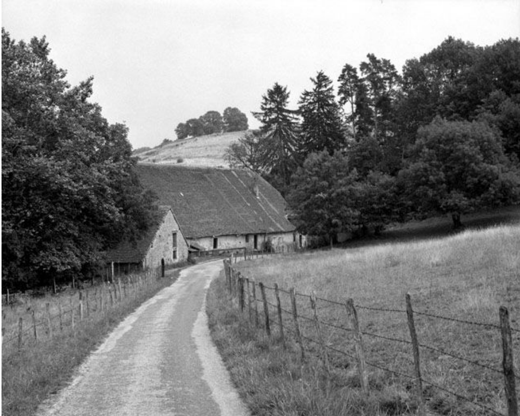
Les parties agricoles vues depuis l'ouest.
