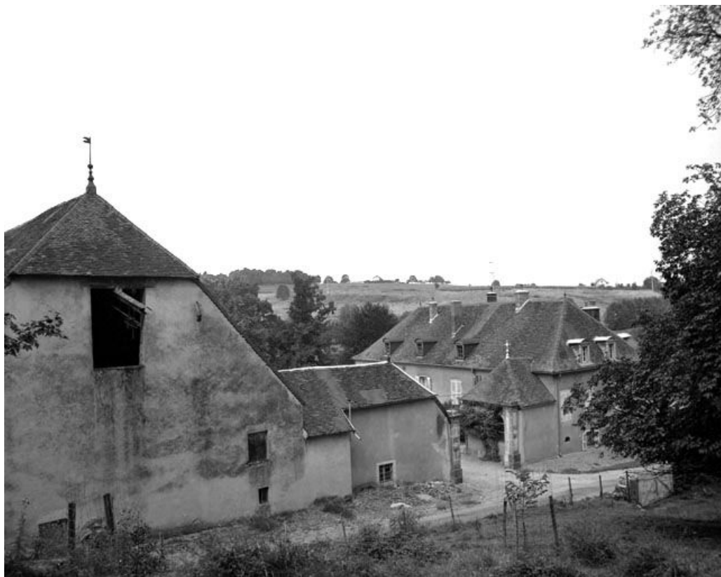
Vue depuis le sud-est.
