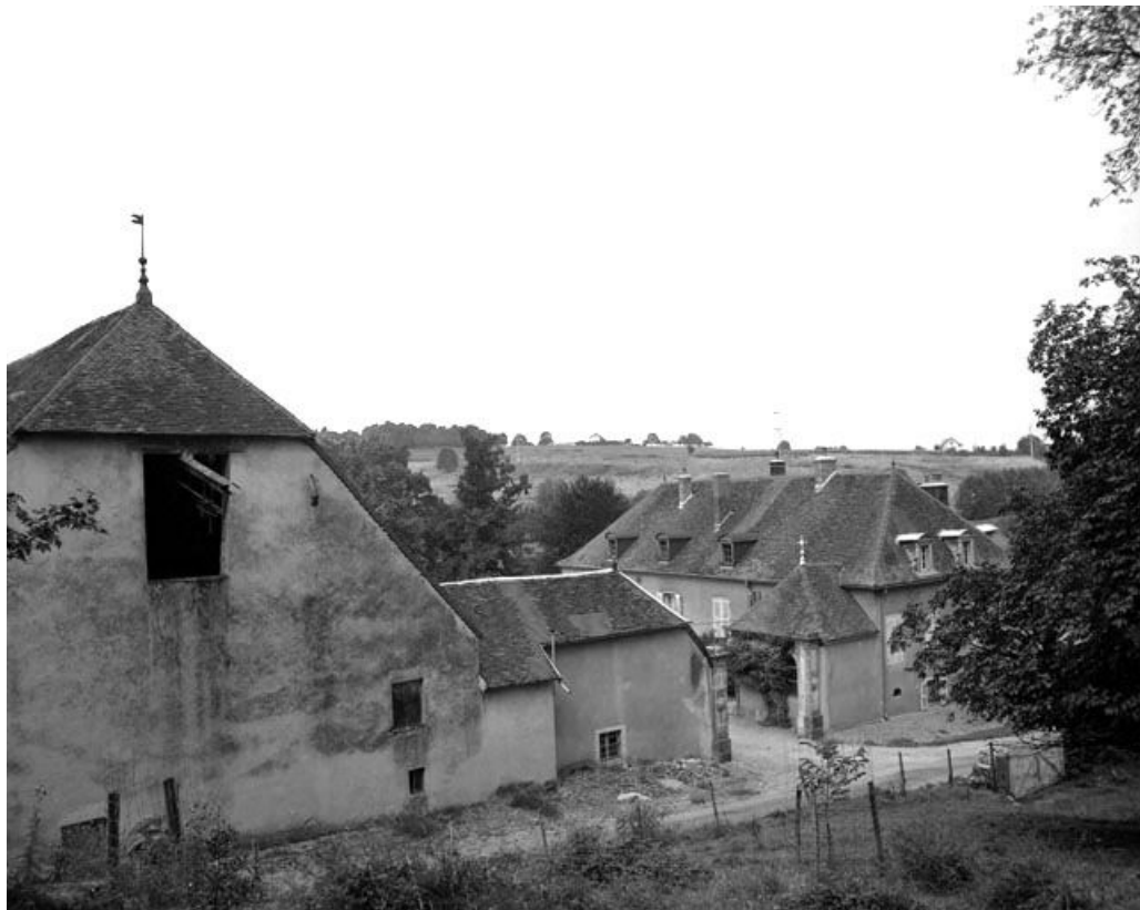
Vue depuis le sud-est.
