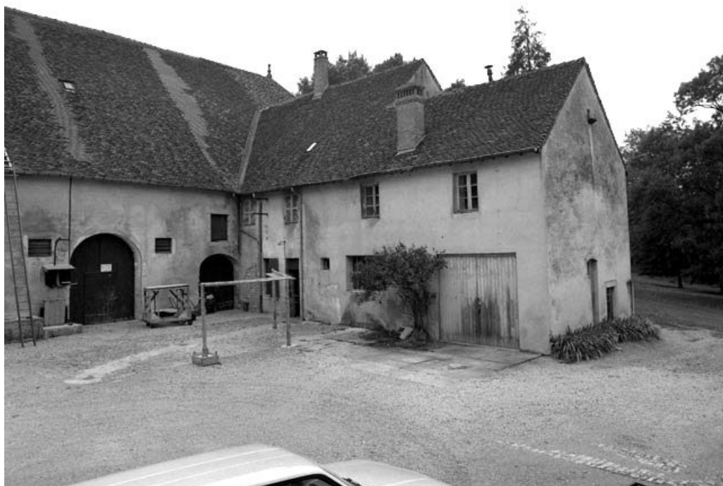
Les parties agricoles, partie droite : élévation sur la cour.
