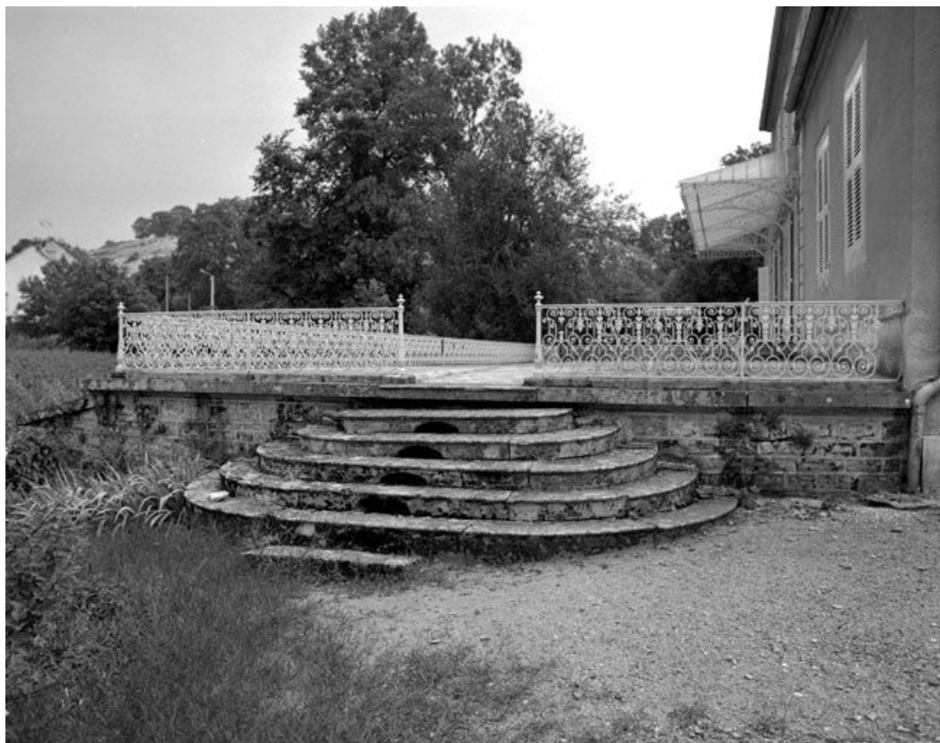
Le degré de la terrasse.
