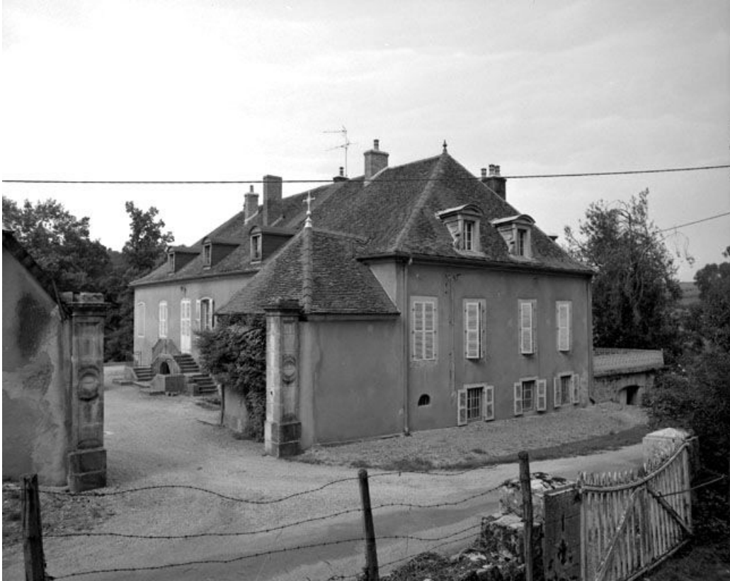
Vue du logis depuis le sud-est.
