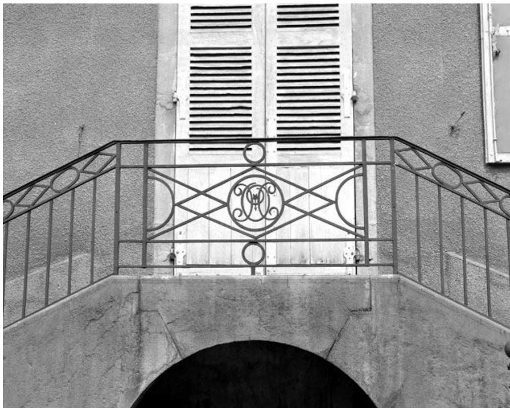
Façade antérieure du logis : détail du perron.
