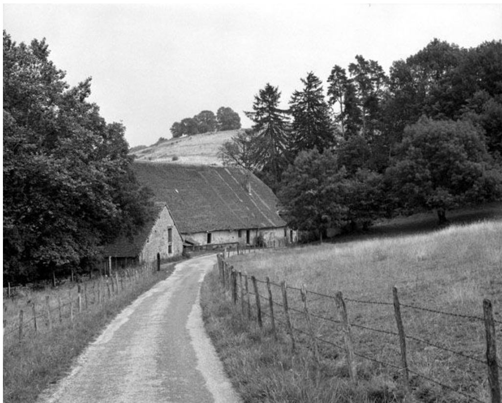
Les parties agricoles vues depuis l'ouest.
