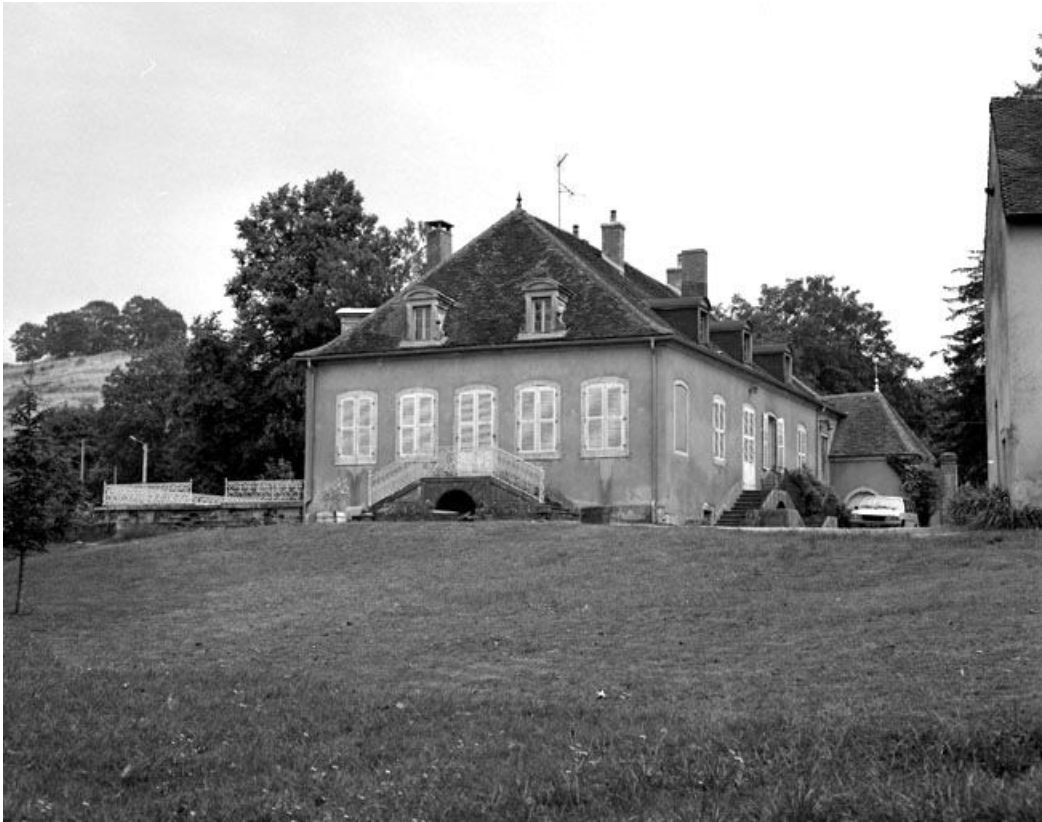
Façade droite du logis.
