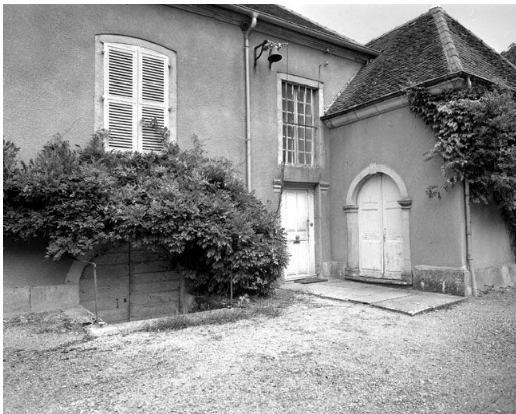
Façade antérieure du logis : partie droite.
