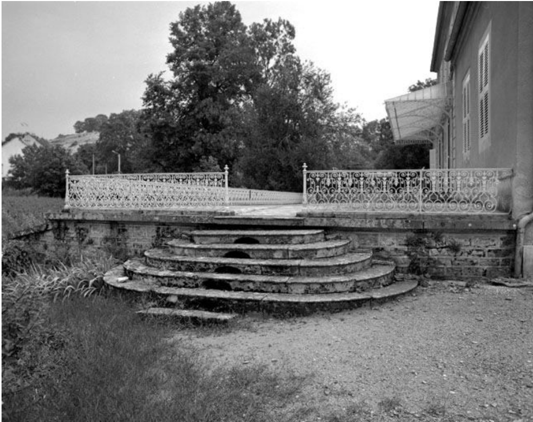
Le degré de la terrasse.
