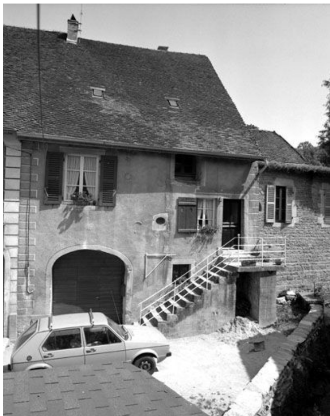
Façade antérieure vue de face.
