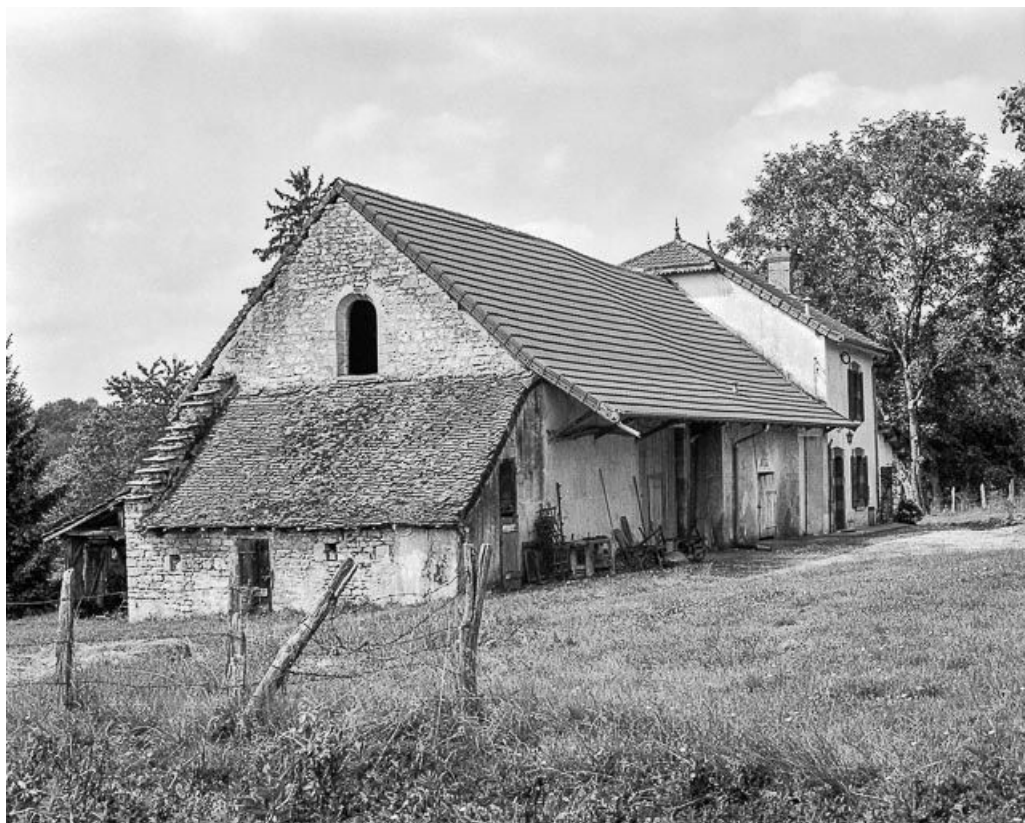
Vue de la chapelle.
