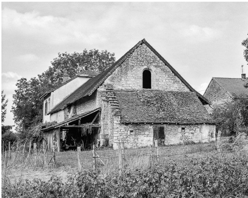
Vue de la chapelle.
