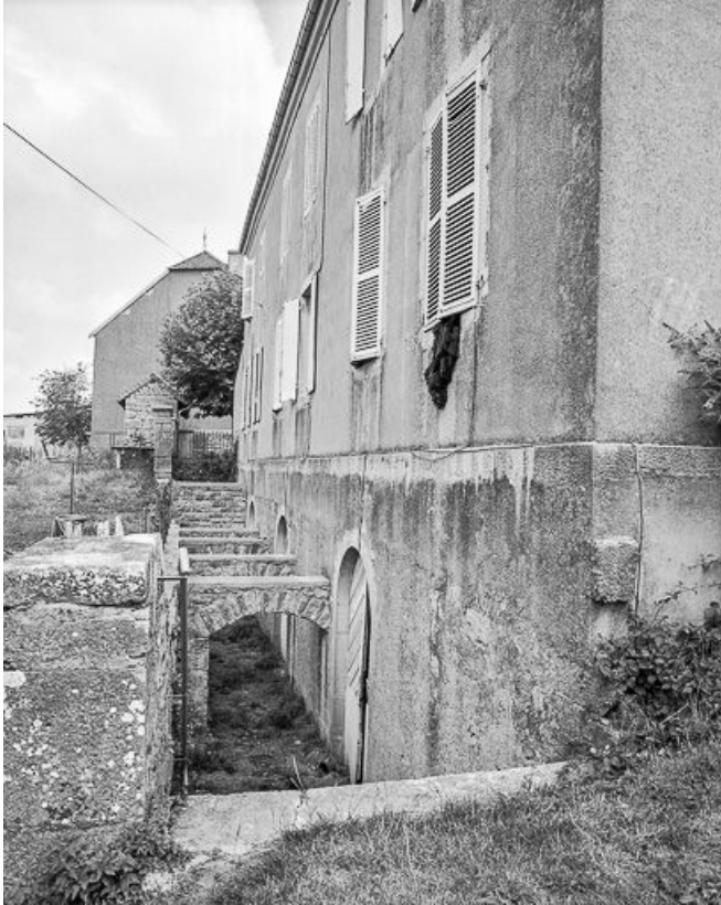
Détail du soubassement de la façade postérieure.
