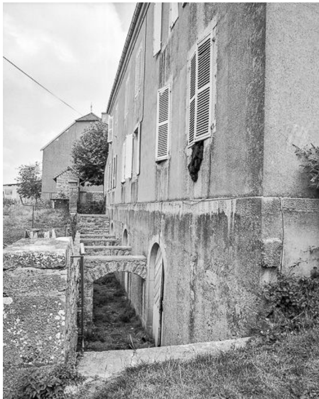
Détail du soubassement de la façade postérieure.
