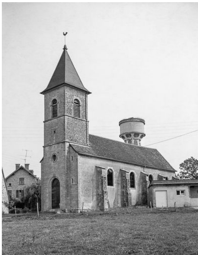
Façade antérieure et face droite.
