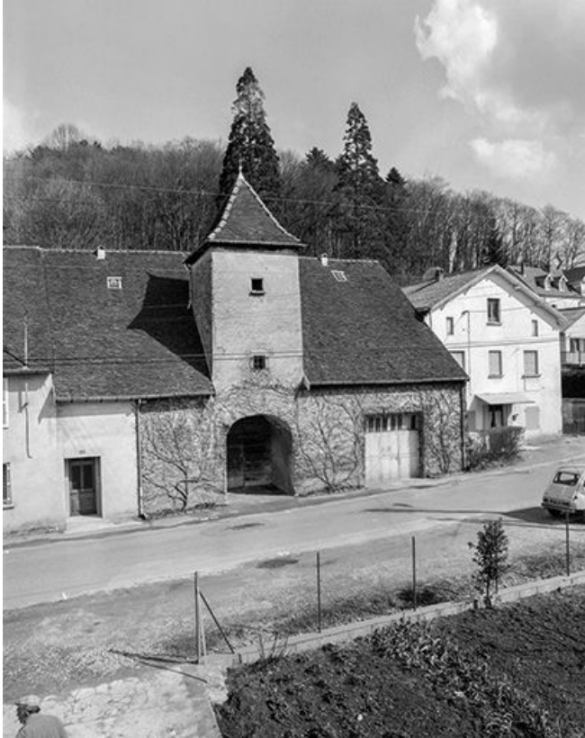
Façade antérieure, vue de face.
