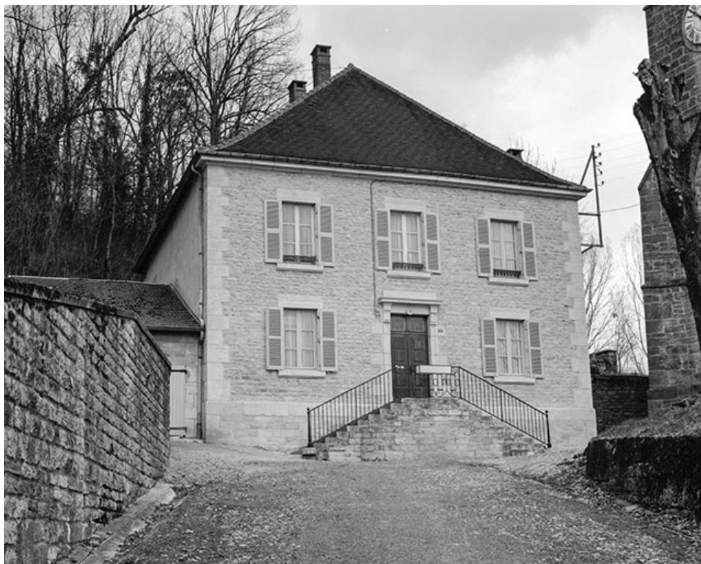
Façade antérieure, vue de face.
