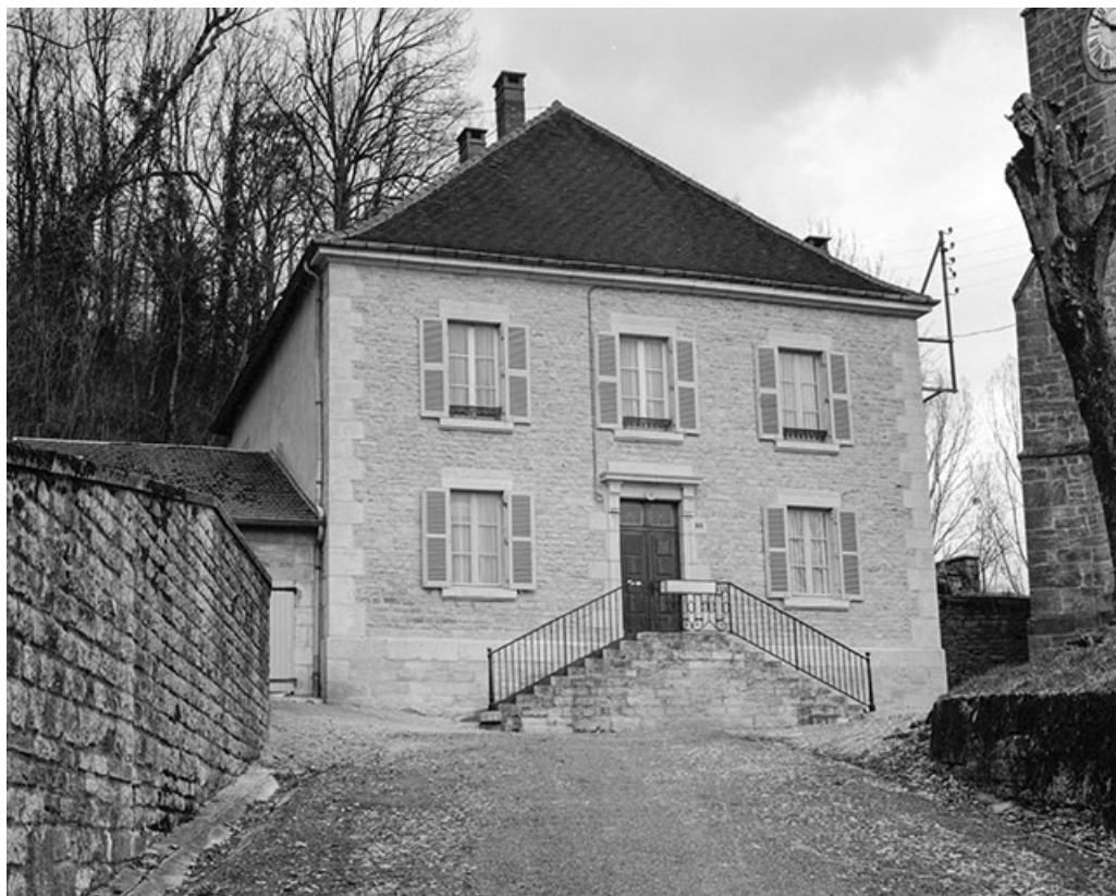
Façade antérieure, vue de face.
