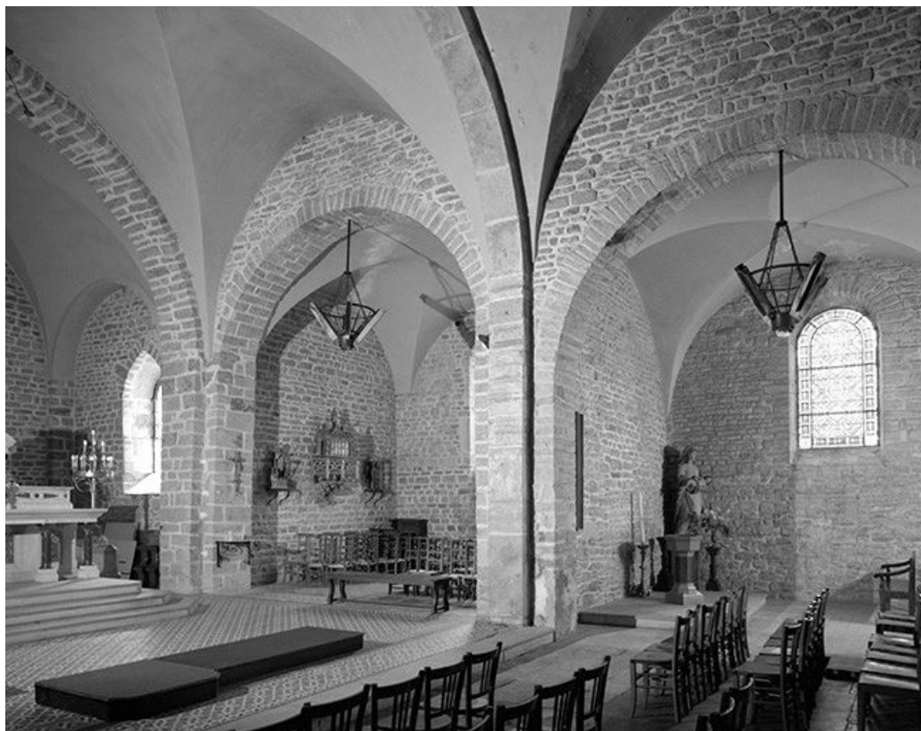
Élévation intérieure droite.
