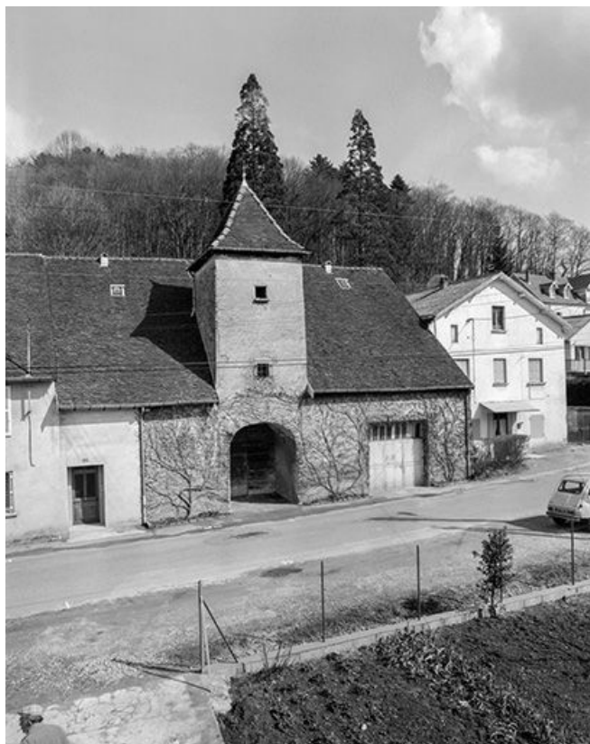
Façade antérieure, vue de face.
