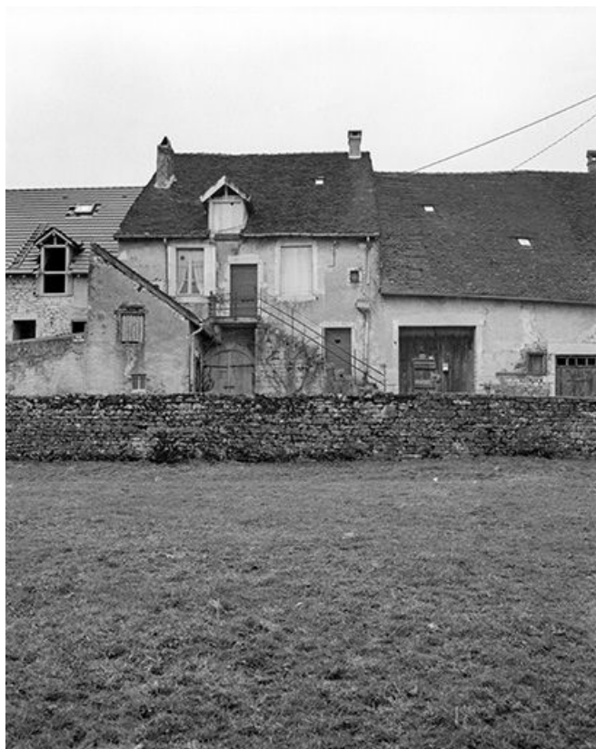
Façade antérieure, vue de face.
