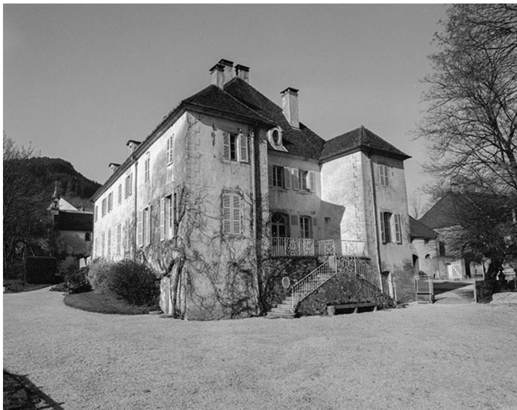
Logis : façade nord.
