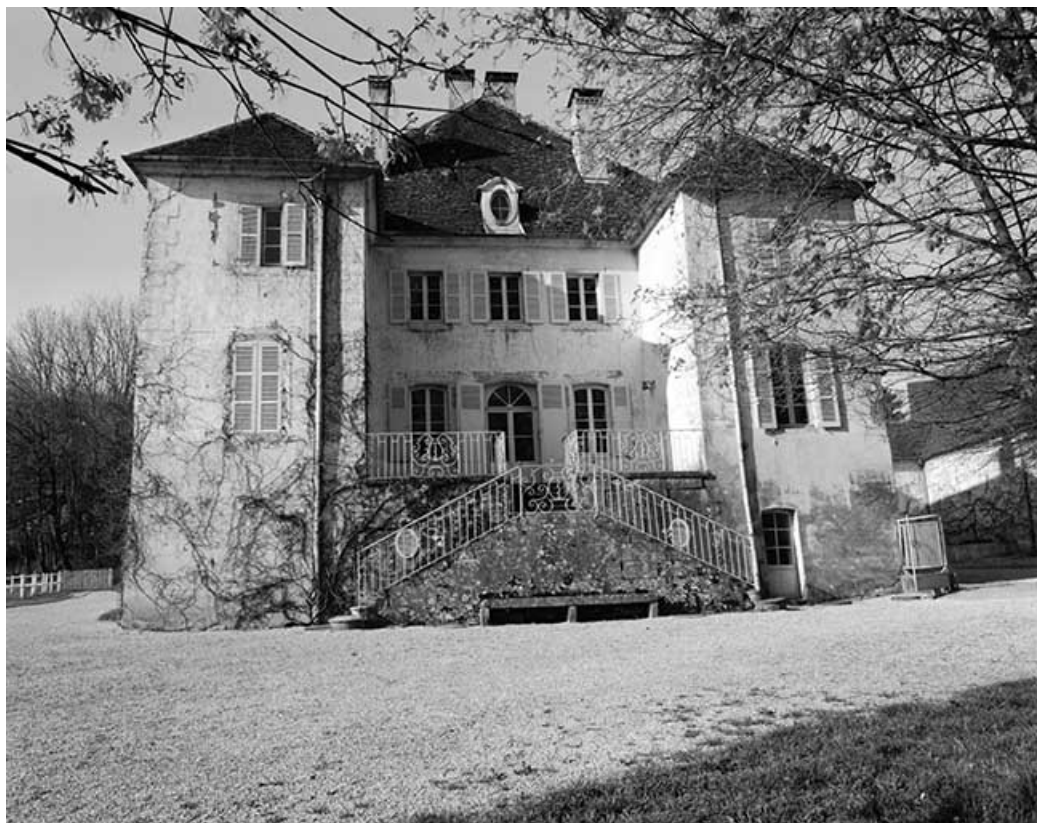
Logis : façade nord.
