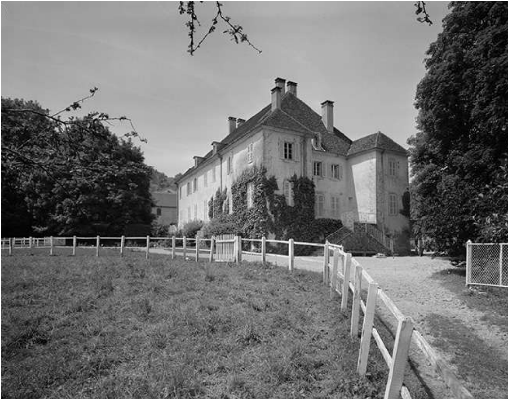
Logis : façades nord et ouest.
