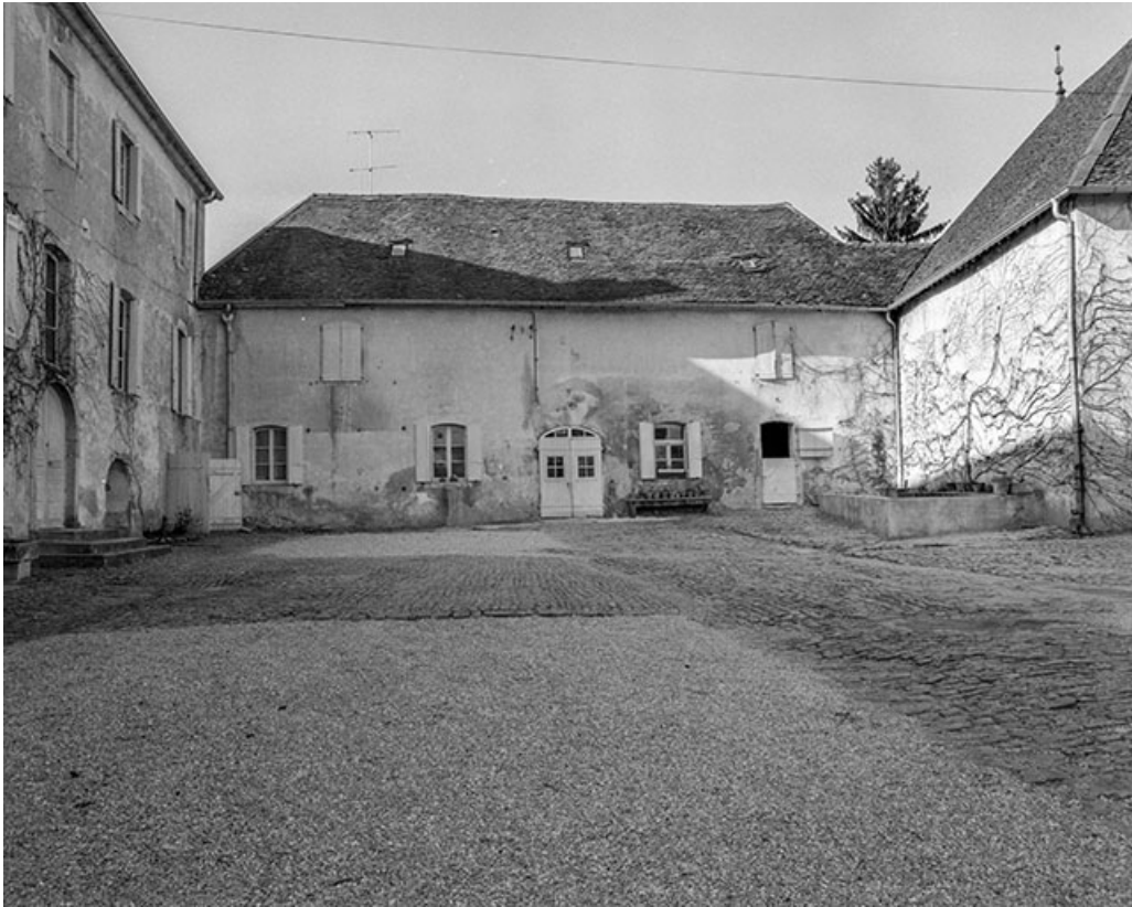
Les communs : façade sur cour.
