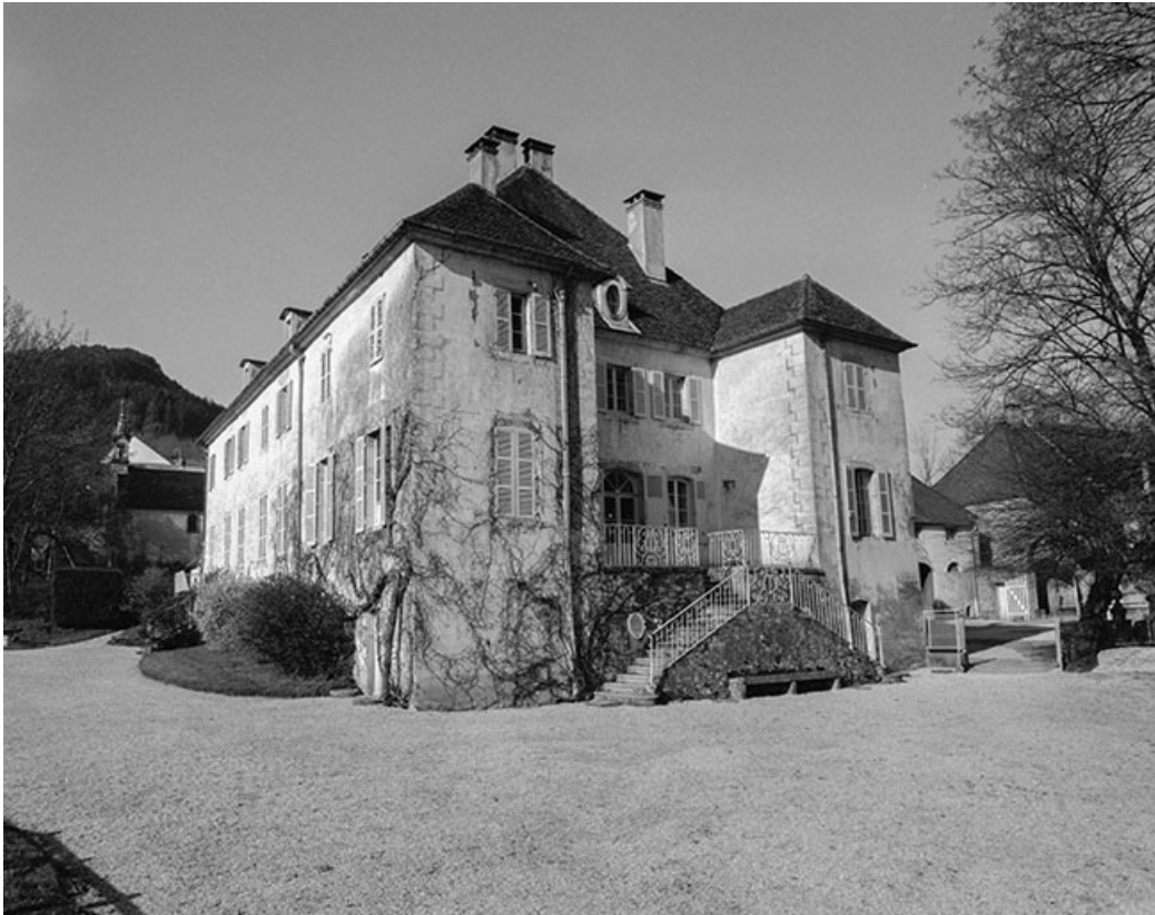
Logis : façade nord.
