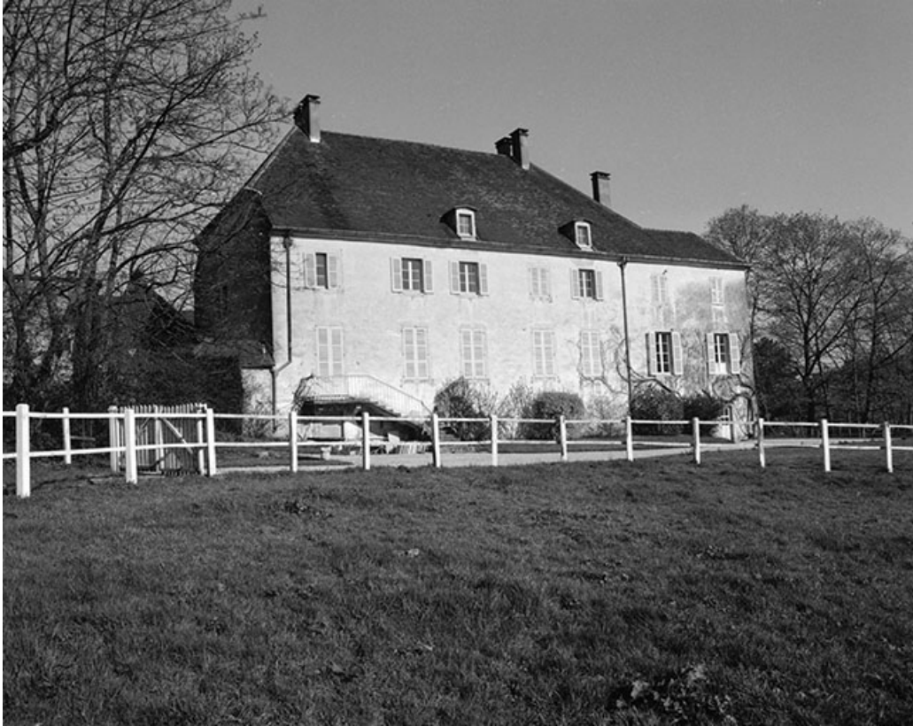
Logis : façade ouest vue de trois quarts gauche.
