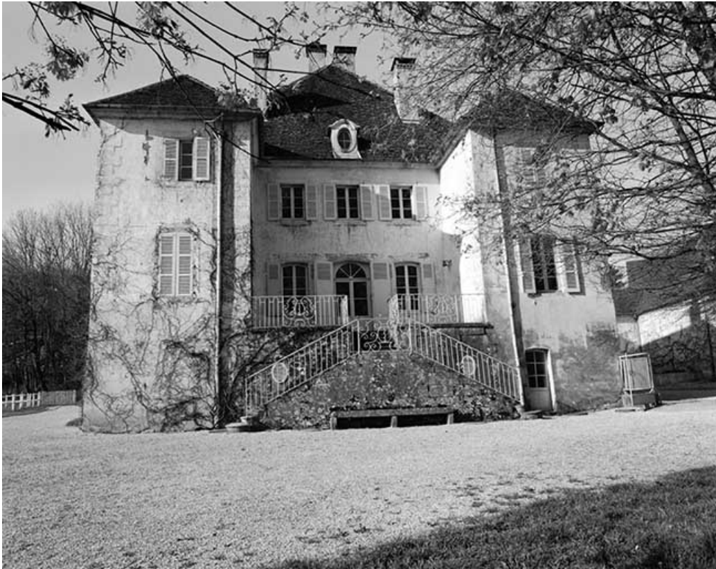
Logis : façade nord.
