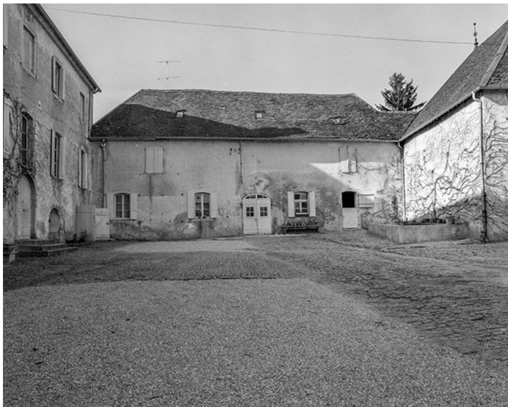
Les communs : façade sur cour.
