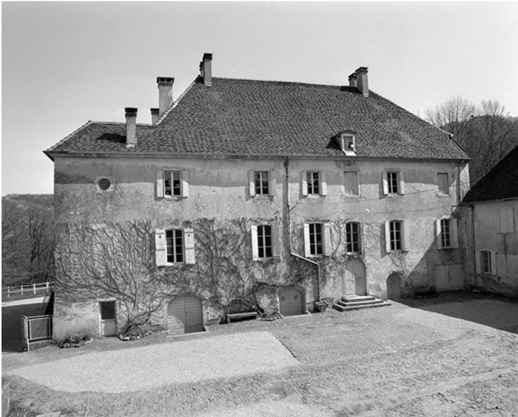
Logis : façade sur la cour.
