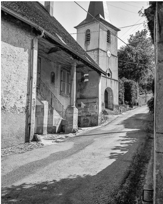
Façade antérieure : partie droite vue de trois quarts gauche.
