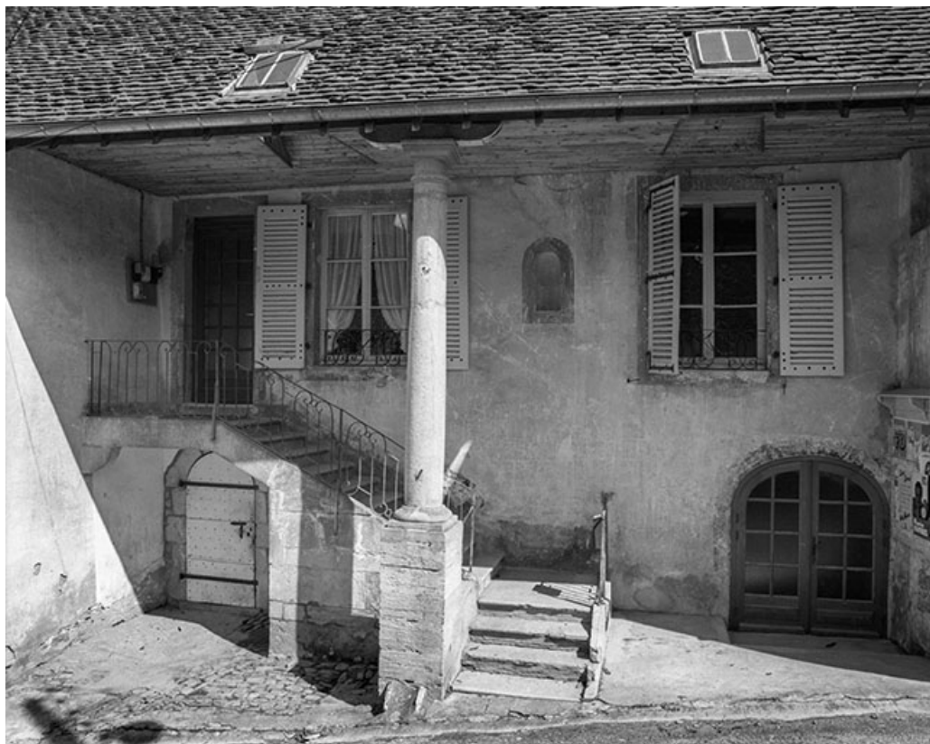
Façade antérieure : partie droite vue de face.
