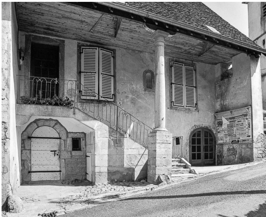
Façade antérieure, partie droite.
